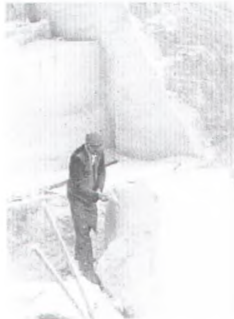
Abb. 7: Formatierung eines Rohblockes mit einem schweren Hammer (Bildarchiv Inst. f. Ingenieurgeologie, TU-Wien).
