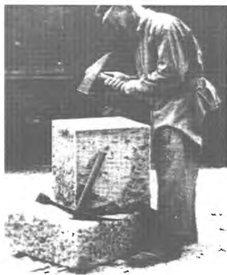
Abb. 24: Mit dem Visieren über das Maßbrett wird die Arbeitsebene festgelegt, die vom Randschlag (Saumschlag) umgeben ist (um 1930).
