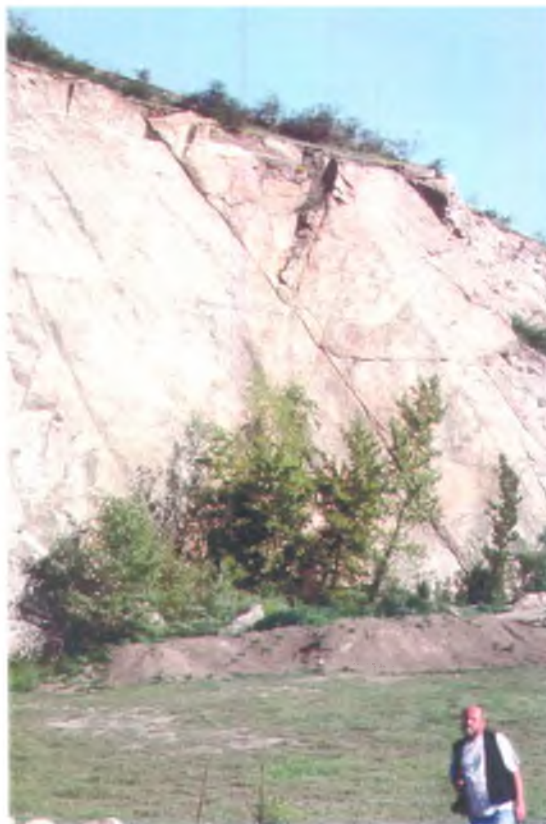
Abb. 30: Abbau entlang steil stehender Klüfte im moravischen Granit (Steinbruch bei Retz).
