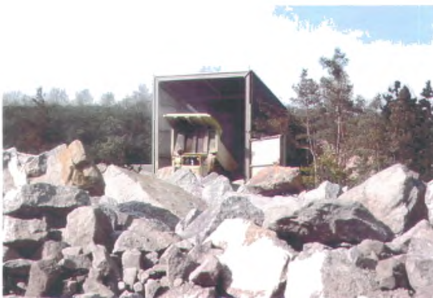
Abb. 32: Ein Muldenkipper schüttet das durch Sprengung gewonnene Haufwerk in den Vorbrecher (Steinbruch Limberg).
