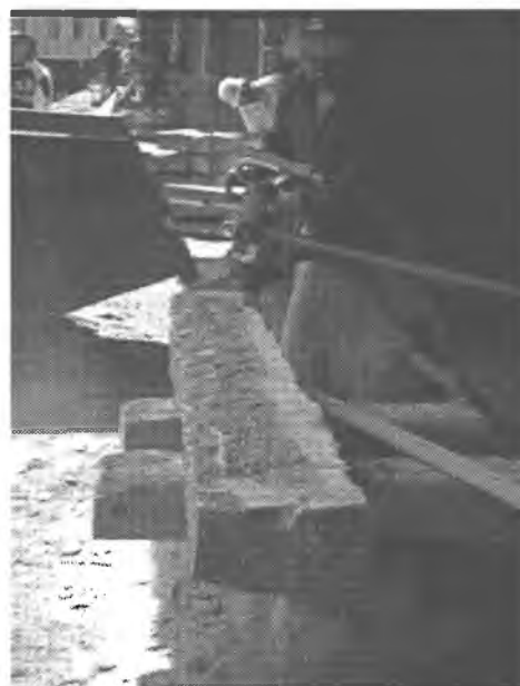
Abb. 27: Stocken mit dem Preßlufthammer.
