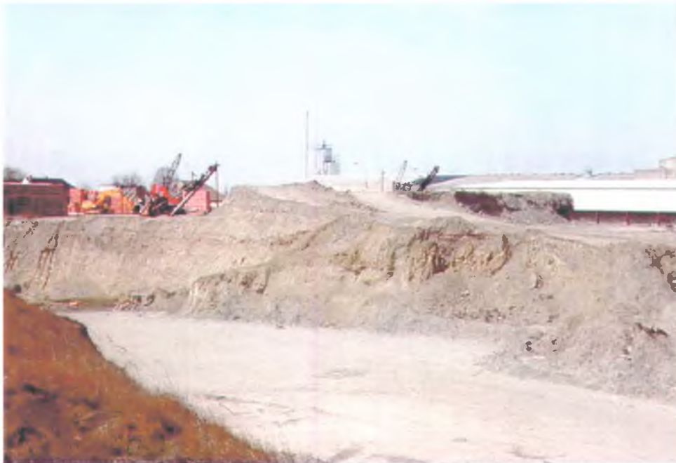
Abb. 34: Abbau von Tonen mit dem Löffelbagger in der Tongrube Laa an der Thaya.
