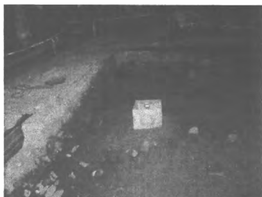
Abb. 15: Aufgefüllte Baugrube mit Piezometer
