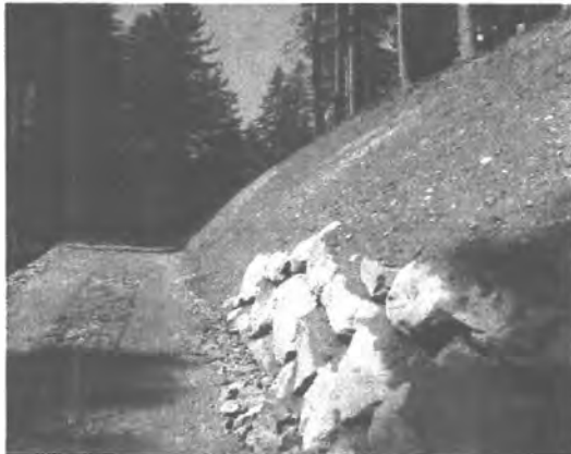
Abb. 11: Trasse mit Wurfsteinmauer
