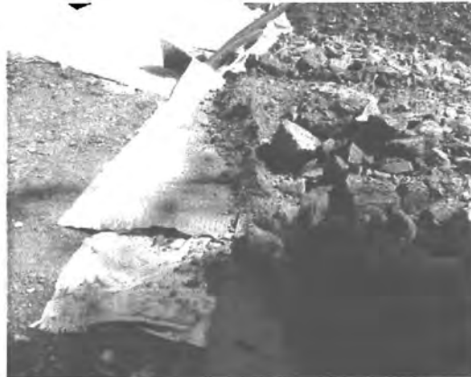
Abb. 12: Vlies, Geotextil, Ableitungsrohre
