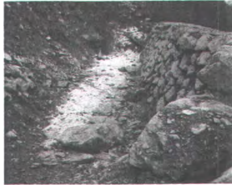
Abb. 4: Felsblöcke hinter Schutzwand
