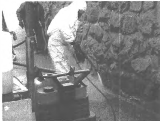
Abb. 14: Reinigung der Straßenoberfläche
