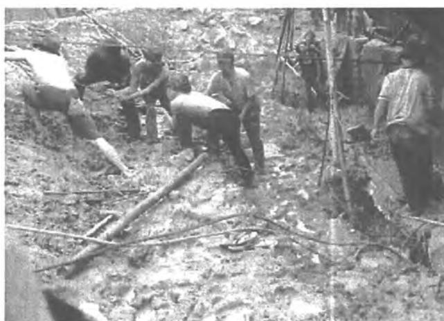
In einer weiteren, unmittelbar anschließenden Projektphase wurde die Sicherung des abgeflachten Oberhanges mittels einer Spritzbetonsicherung und der Herstellung von Passivankern projektiert. Weiters sollte der Unterhangbereich schließlich mittels Aktivanker in einer dritten Ausführungsphase die Langzeitstabilität gewährleisten. Die Bemessung aller Maßnahmen erfolgte durch laufende begleitende Berechnungen nach Vorliegen der Bohrergebnisse.
