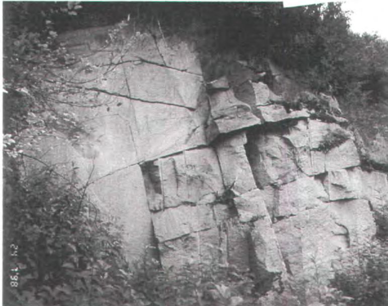
Abb. 6: Gesamtansicht der Felsböschung auf der zweiten Etage mit bergwärts einfallenden Lagerklüften
