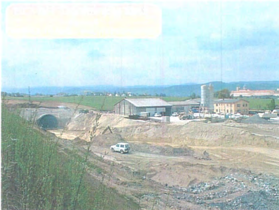
Abbildung 1-10: Baustelle des Melker Tunnels (Ostportal)
