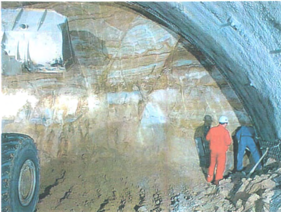
Abbildung 1-4: Melker Sand im Wachberg Tunnel (Kalotte)
