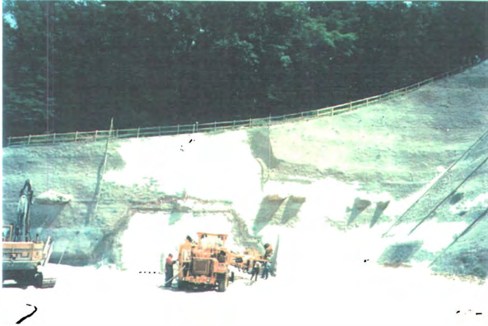
Abbildung 1-2: Wachbergtunnel Westportal Voreinschnitt in hellgrauen bis gelbgrauen Melker Sanden. Auffällig sind die horizontgebundenen verhärteten Konkretionen.
