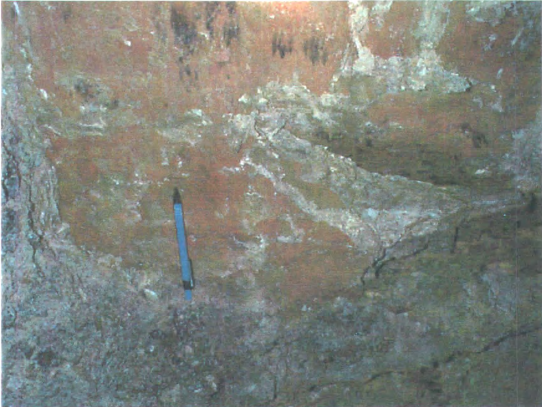
Abbildung 7: Harnischfläche mit Striierung und oxidierten Kluffflächenbelägen im Kienberg-Fluchtstollen
