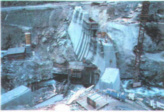
Abb. 40: Sperre Paal, rechte Einbindung, ohne Vorlandplombe
