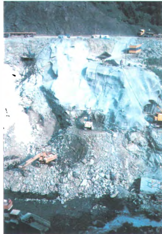
Abb. 37: Sperrre Paal, Felsfreilegungen
