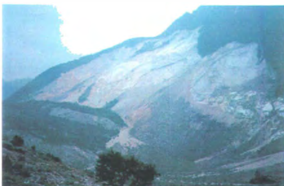
Abb. 24: Vajont-Sperre, Riesenbergrutschung im Zuge der Stauerichtung
