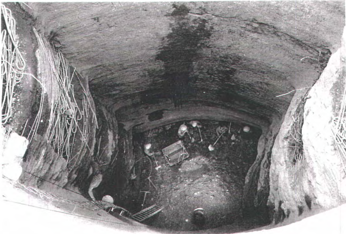
Abb. 33: Blick in eine Baugrube. (Der elliptische Querschnitt zeigt, daß die links und rechts liegenden Brunnen bereits abgeteuft und ausbetoniert sind. Im Schutze einer Torkretschalung arbeitet sich die Aushubpartie bis zum tragfähigen Boden in 30 m Tiefe vor.)
