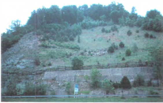
Abb. 27: Hangrutschung Gratkom-Tunnel Nord
