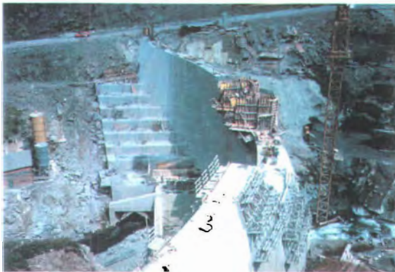
Abb. 41: Sperre Paal, Vorlandplombe in Bau
