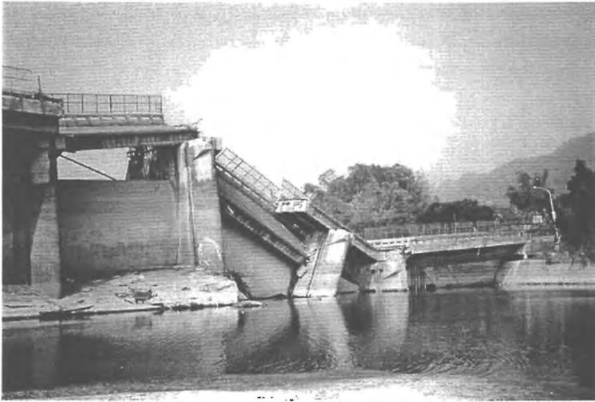
Abb. 6: Zerstörter Abschnitt der Shi-Kang Sperre. Ansicht von der Wasserseite
