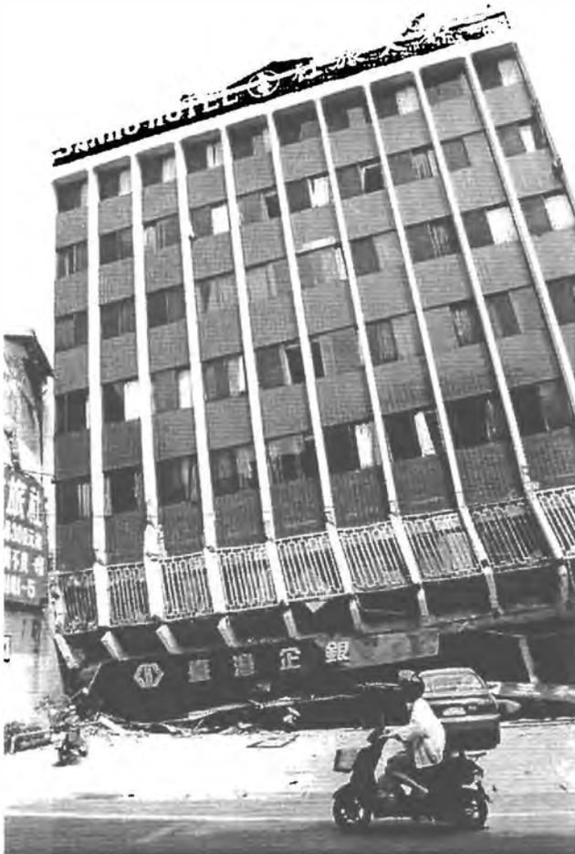
Abb. 9: Schäden an einem mehrstöckigen Haus durch Abscheren des untersten Stockwerkes
