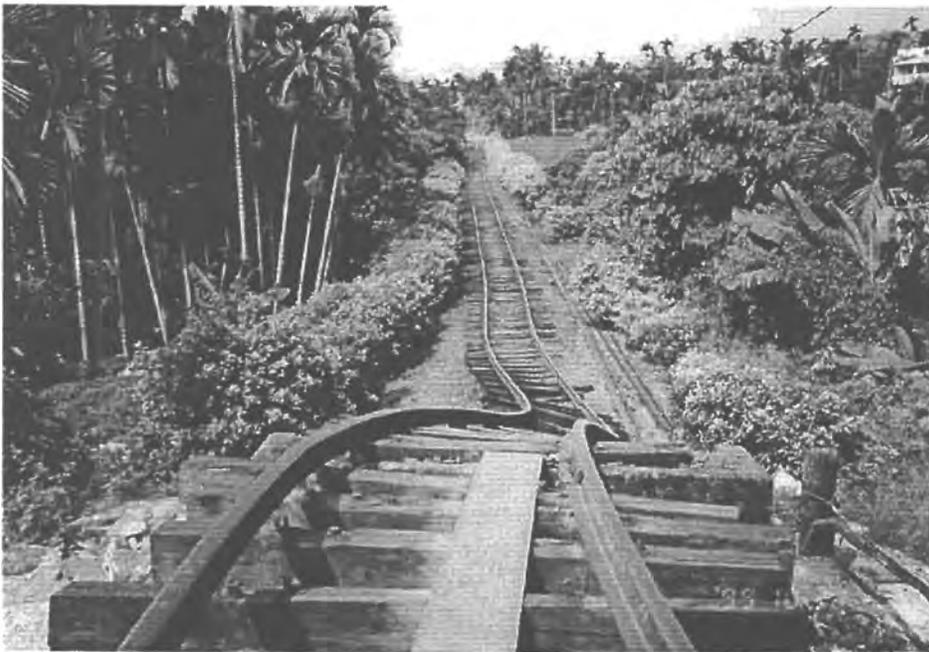
Abb. 8: Charakteristische Hebung im Hangenden der Chelongpu Störung
