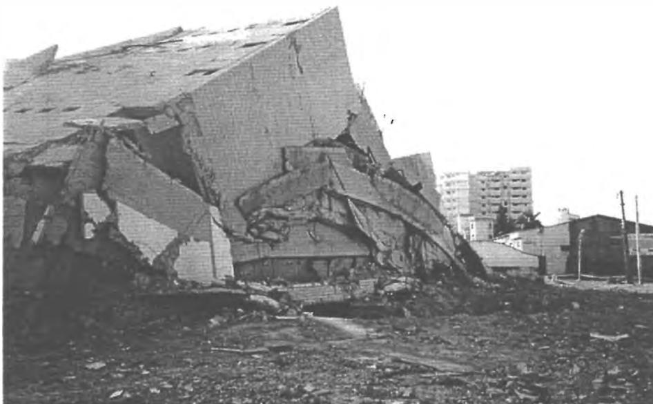
Abb. 10: Totalschaden verursacht durch Untergrundschwingungen
