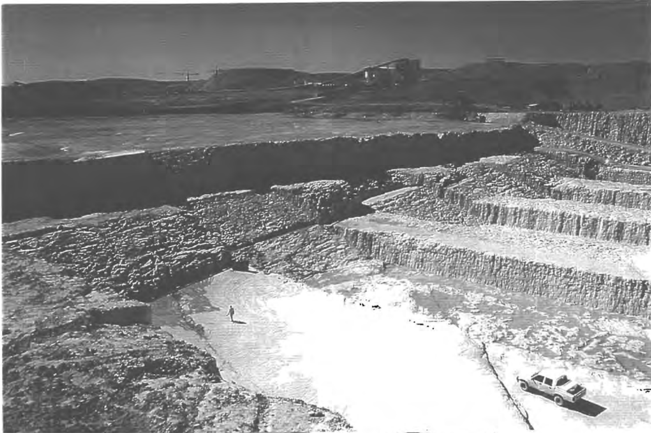
Abb.1: Aushub Tosbecken, Blick nach Süden; flaches Einfallen der Schichten nach NW, deutlich erkennbarer Ausbiß der Tonlagen
