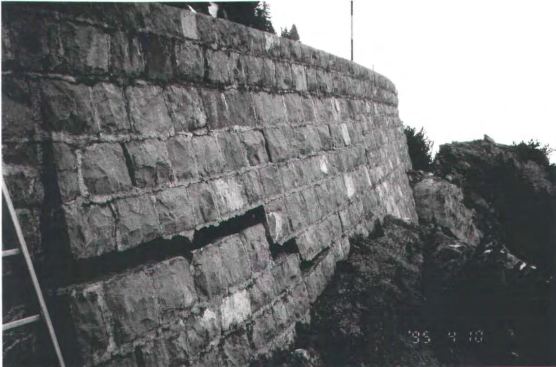
Abb. 13: Auflösung der Stützmauer Posteck – Rauz der B 197
