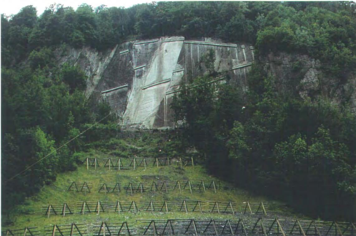
Abb. 4: Ansicht der fertiggestellten Sicherung Felssturz Engelwand S 16
