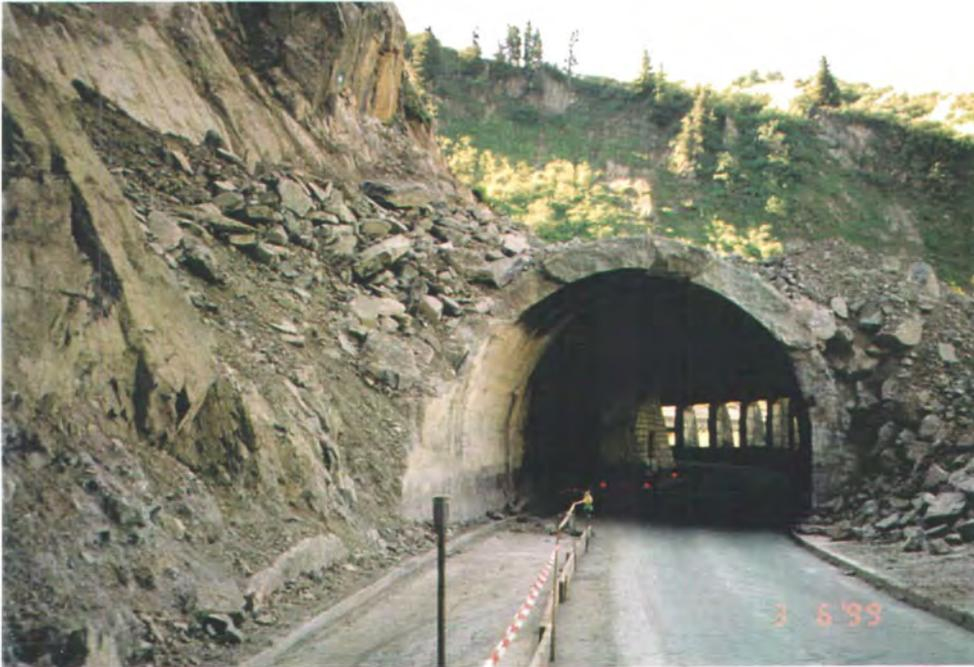
Abb. 11: Felssturz Steinbruchtunnel am 2.7.1999
