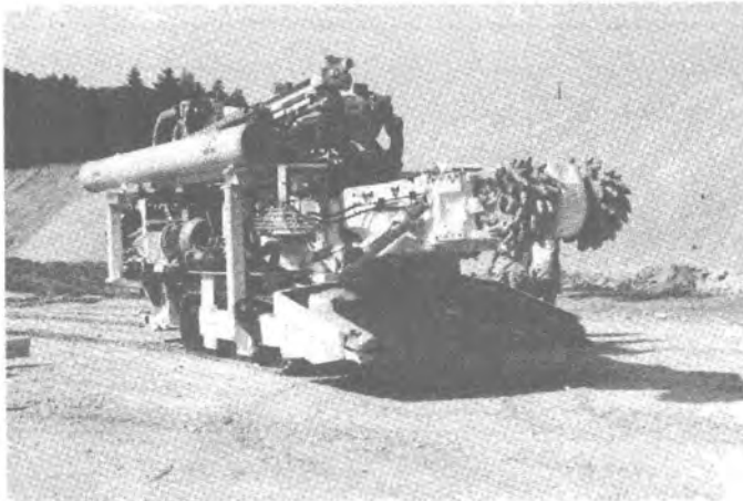
Abb. 8: Anlieferung der Teilschnittmaschine
