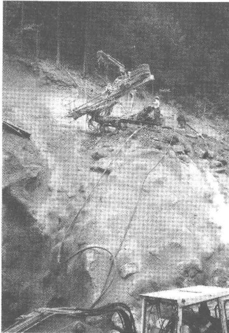
**Bild 6:** Bohrgerät auf der ersten Aushubetage
