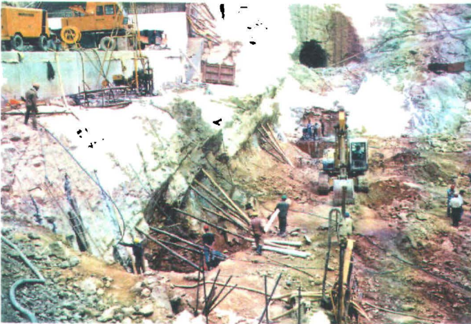
Abb. 9 Ausräumen der 4 m mächtigen Plunge Pool Fault. Die Störung fällt mit 65° nach Norden. Der luftseitige Mauerfuß verläuft links vom Bagger. In der linken oberen Bildecke sind einige Betonblöcke für das Tosbecken erkennbar. Das Stollenmundloch am oberen Bildrand ist der Injektionsstollen RGG-0. Die Sohle des Aushub liegt 20 m unter der ehemaligen Talsohle. Blickrichtung nach Osten.
