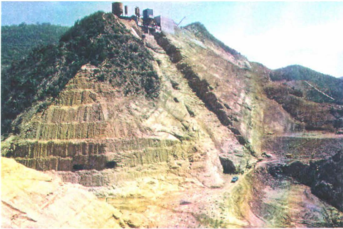
Abb. 1 Blick nach Osten auf das rechte Widerlager und in die Schlucht des Tajan Rivers. Die Ausbül- linien der nordfallenden Schichten ziehen von rechts oben zur Bildmitte nach unten. 1500 t - Zementsilo, Betonmischanlage, Kiesbunker und Arbeitsplattform sind fast fertiggestellt (oberer Bild- rand). Linke Bildmitte Felsabtrag für das Tosbecken mit zwei Untersuchungsstollen.
