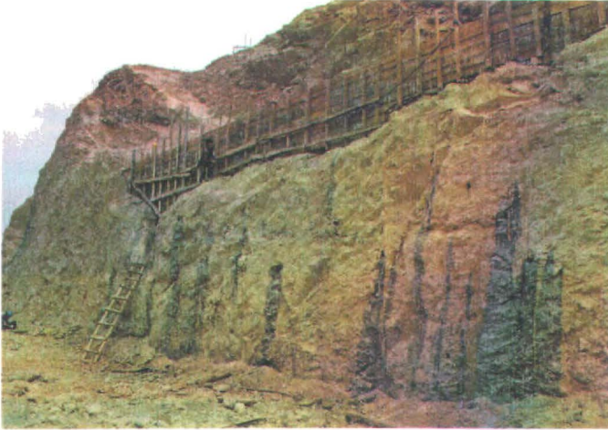
Abb. 11 Blick auf die Basisschalung für das Fundament der Kiesbunker. Die Schalung steht auf völlig zertrümmertem Kalk der 8 m mächtigen 493-Störung (strichliert). Die Störung fällt flach nach SE ein. Hangendes und Liegendes sind intensiv tektonisiert. Blickrichtung ist Nordwest. Zementfahnen der Konsolidierungsinjektionen sind deutlich erkennbar.
