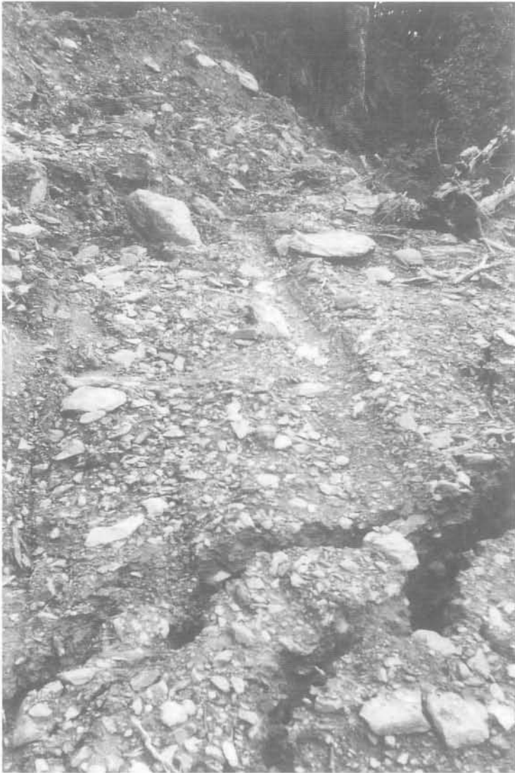
Abb. 9: Klaffende, gestaffelt angeordnete Zerrspalten am Südrand der Rutschung, im Bereich des mittleren Weges, zeigen die hohe Aktivität im Jahre 1992, sowie Scherdeformation am Rand der Rutschung an.
