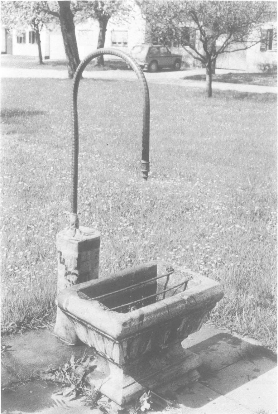
Artesischer Dorfbrunnen in Übersbach, Tiefe 110 m, Schüttung 3,5 l/min
