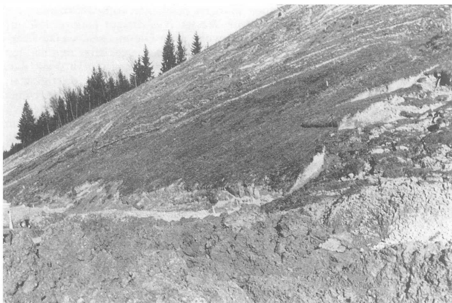
Abb. 23. Südautobahn westlich Gleisdorf
