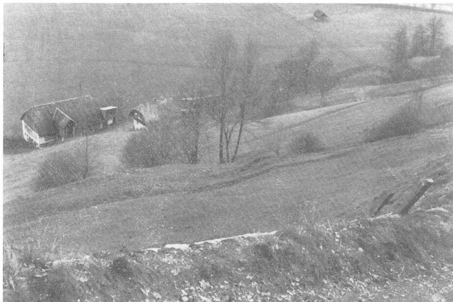
Abb. 9. Ennstalbundesstraße westlich Gröbming
