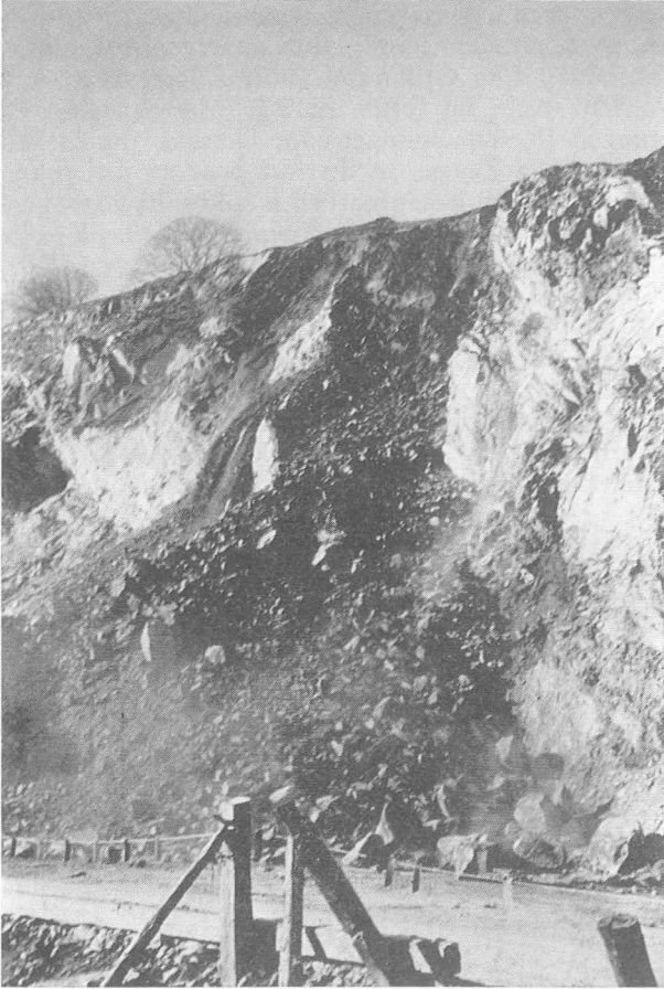
Abb. 12. EnnstalBundesstraße bei Mandling
