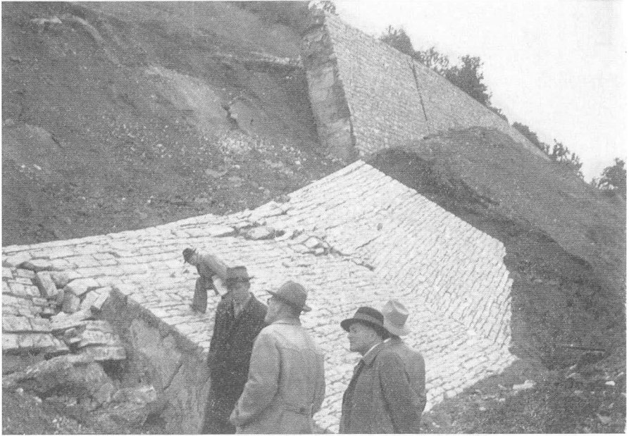
Abb. 10. Ennstal Bundesstraße westlich Gröbming
