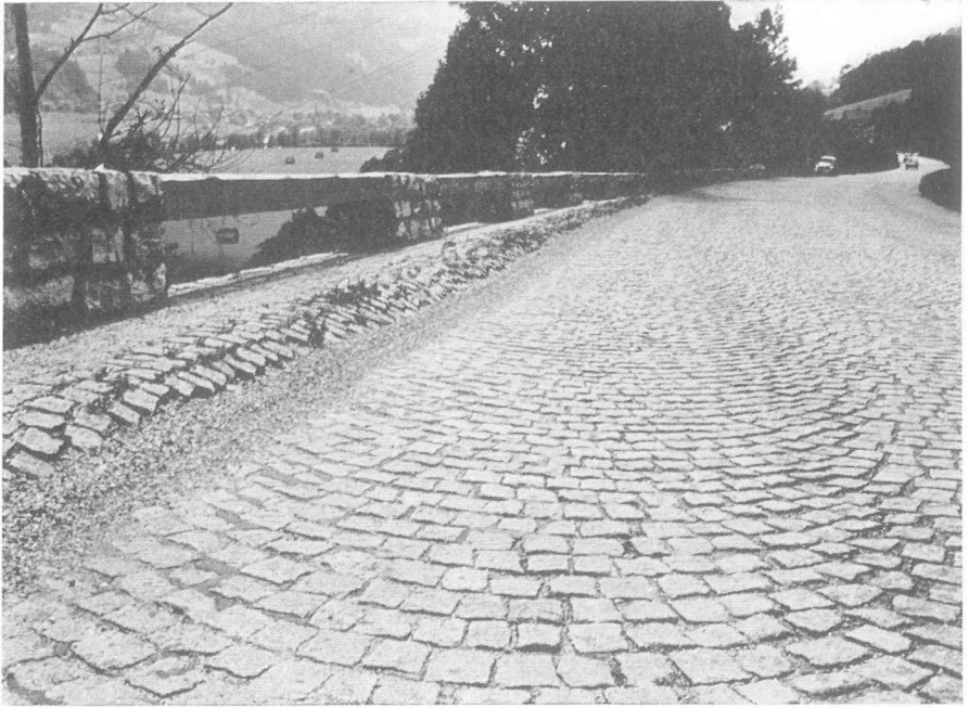
Abb. 11. Ennstalbundesstraße westlich Gröbming
