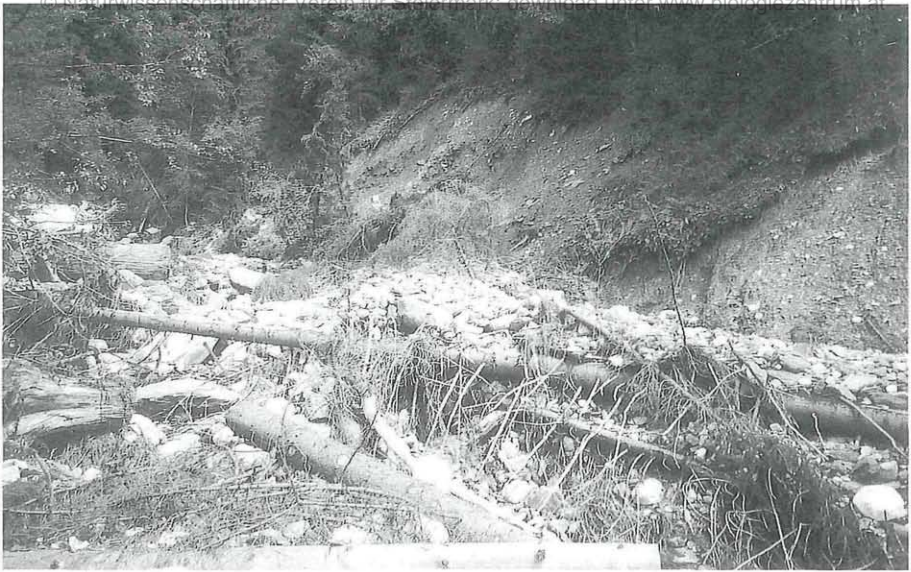
Abb. 3: Ufereinbrüche im Bereich des mittleren Feistergrabens bei Seehöhe 1115 m. Diese liefern nicht nur einen Großteil der Feststoff- und Geschiebefracht des Wildbaches, sondern auch Treibholz, welches das Verkläusungsvermögen beträchtlich steigert. Lage siehe Abb.1. Erosion of coluvial debris along riverside of the middle part of Feister river during highest magnitude of the flood event as a source of both, sediment load as well as wood which increases possibility of temporary river storage buildings. For location see Fig.1.
