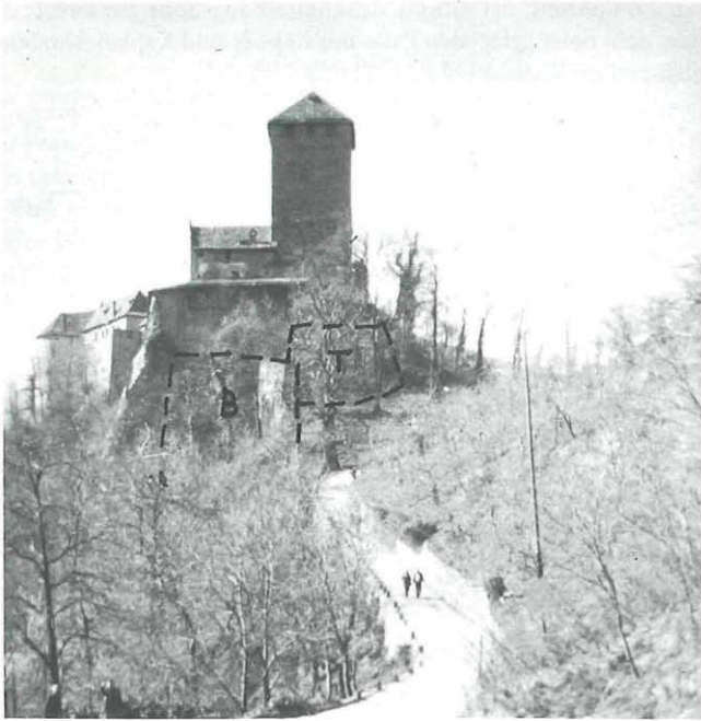
Abb. 3: Ansicht von Schloß Tirol von Norden. Im Vordergrund Bergfried und Mushaus, im Hintergrund links Kaplanei und Kapelle. Dem Fuß des Bergfrieds ist eine alte Trockenmauer (T) bastionartig vorgebaut, den Untergrund des Mushauses unterfängt eine Bogenmauer (B).
