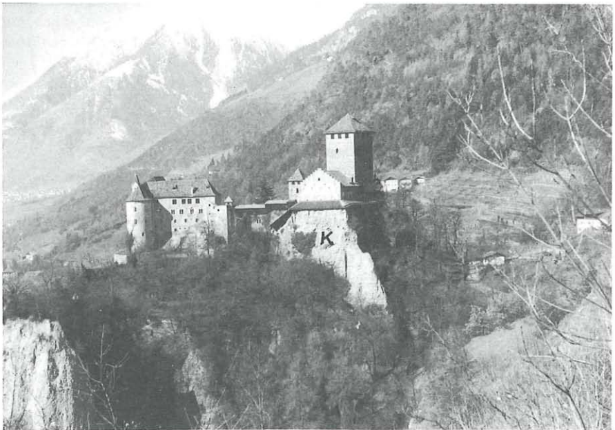
Abb. 1: Ansicht von Schloß Tirol von Osten. Rechts die Baugruppe aus Bergfried und Mushaus, links Kaplanei, Palas und Kapelle. Die Steilabbrüche bestehen aus würmzeitlicher Moräne mit einer Einlagerung von sandigem Kies (K) und tragen eine Überdachung zum Schutz vor Niederschlägen.
