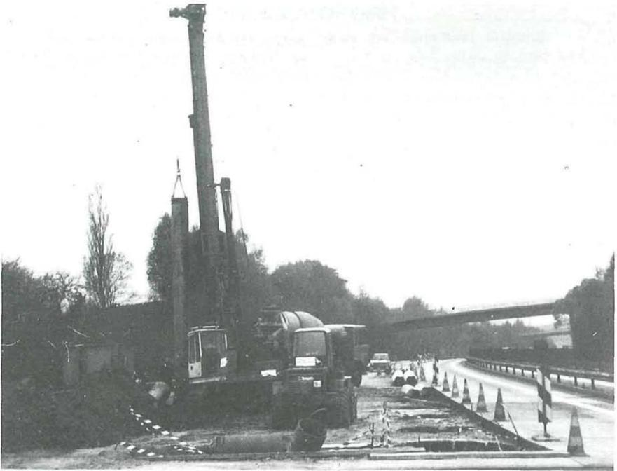
Fotos: Herstellung der Bohrpfähle im Baufeld.
