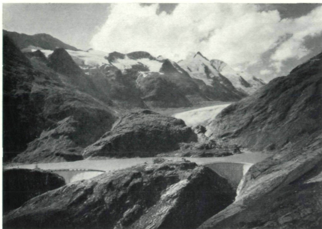
Bild 3: Margaritzensee (2000 m Mh.) mit Margaritzensperre (links, 93 m Höhe) und Möllsperre (rechts, 37 m) auf Kalkglimmerschiefer. Speichernutzzinhalt 3,2 Millionen m 3 mit Möllüberleitung zum Speicher Mooserboden des Tauernkraftwerkes Glockner-Kaprun. Stauraum und Sperrstellen des Margaritzensees lagen in der zweiten Hälfte des vorigen Jahrhunderts noch unter Eis und sind erst durch den anhaltenden Gletscherrückgang der Pasterze freigeworden. Im Hintergrund der Großglockner. Werkfoto der Tauernkraftwerke.
