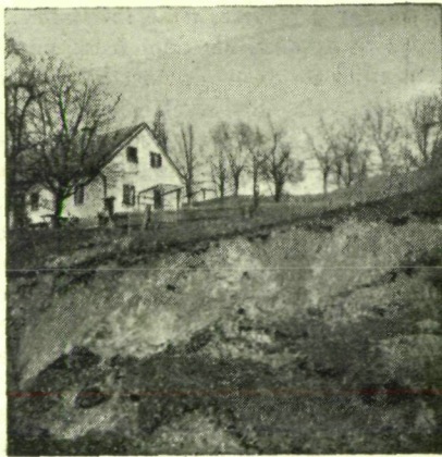
Abb. 5: Der Abbruch ist in bedenklicher Nähe des Hauses erfolgt.
