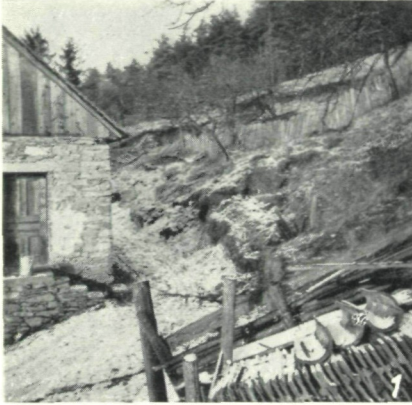
Abb. 1: Rutschung bei Heil in Zeil-Pöllau.
