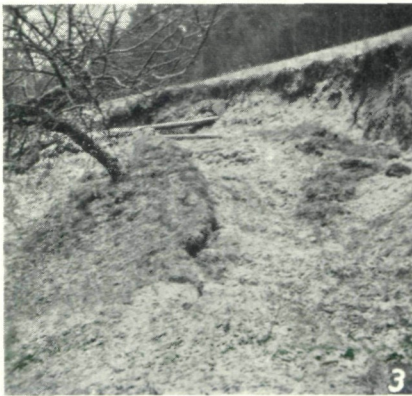
Abb. 3: Rutschungsnische bei Heil in Zeil-Pöllau.
