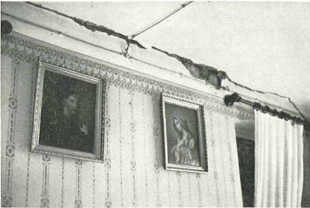
Abriß der Decke von der Zwischenwand.
