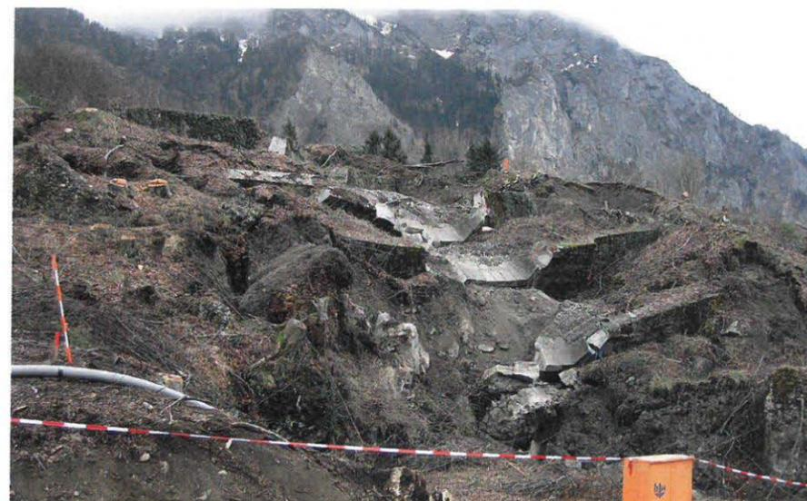
Durch die Rutschung völlig zerstörte Wildbachsperrern im Gschlifgraben.
