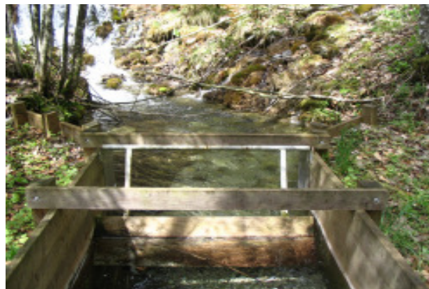
Abbildung 5: Wellenberuhigungsvorrichtung
