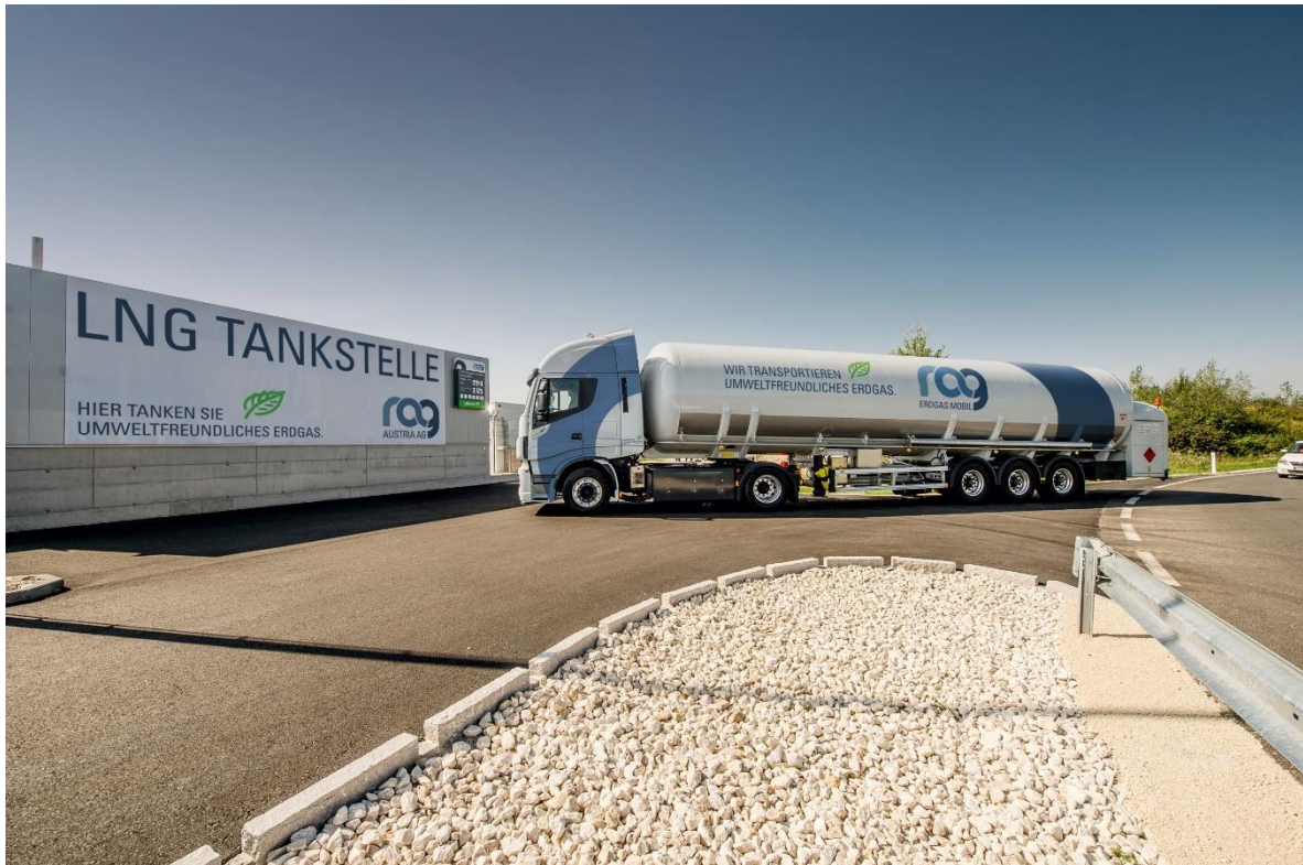
Abbildung 3 LNG Tankstelle der RAG Austria AG
