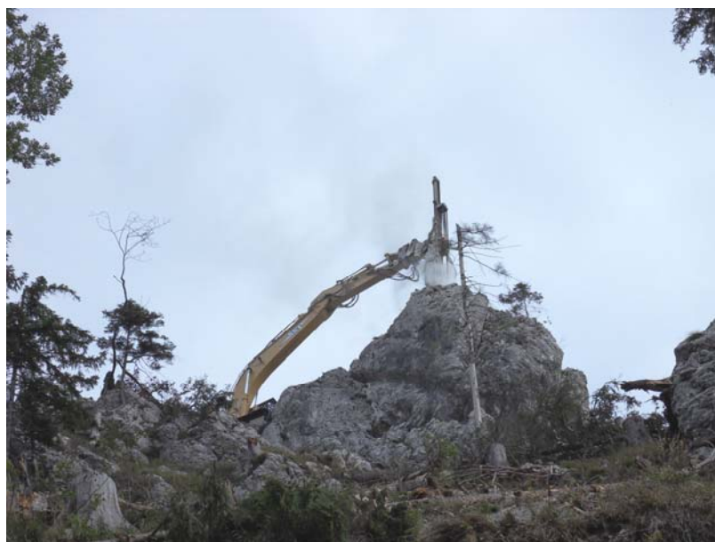
Abb. 7: Sprengung eines Felskopfes im Tagbau Steyrling der voestalpine Stahl GmbH
