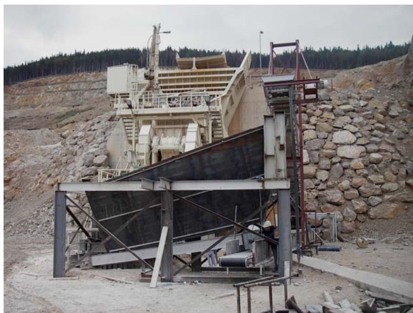
Abb. 4: Spannwellensieb der Wopfinger Baustoffindustrie GmbH
