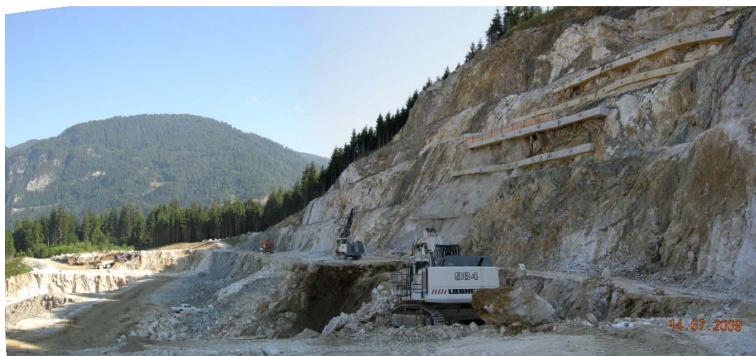
Abb. 6: Herstellen der Endböschung im Bergbau Gummern der Firma Omya GmbH
