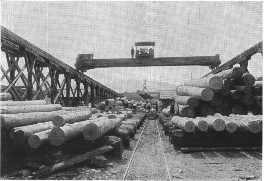
Fig. 11. Eine Holzklotzlagerstätte mit Laufkran.
