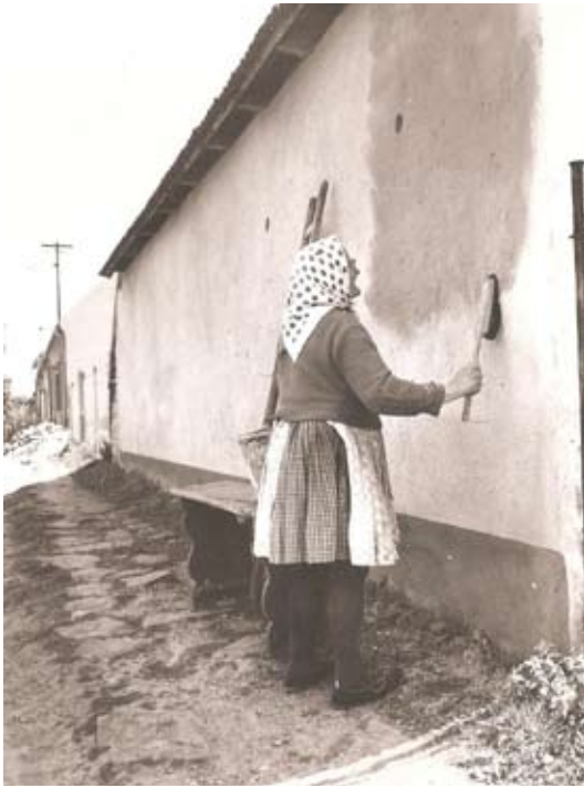
Abb. 2: Dolní Němčí. Die Instandhaltung der Kalkmilch auf den Wänden des Lehmhauses (hier eine Mühle) war traditionell die Pflicht der Frauen
