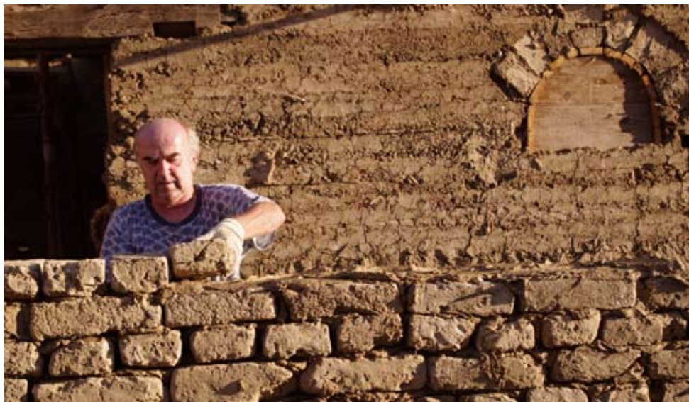
Abb. 1: Mauern der Wand aus ungebrannten Ziegeln. Museum des Dorfes Südostmährens. Foto: M. Novotný 2013.
