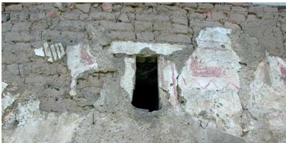
Abb. 2: Detail der Außenwand aus ungebrannten Ziegeln vom Ende des 16. Jhdts., mit Überresten des Verputzes mit handgemalter geometrischer Verzierung; Dědibaby Nr. 4 (Bezirk Mělník); Foto: Zuzana Syrová 2002
