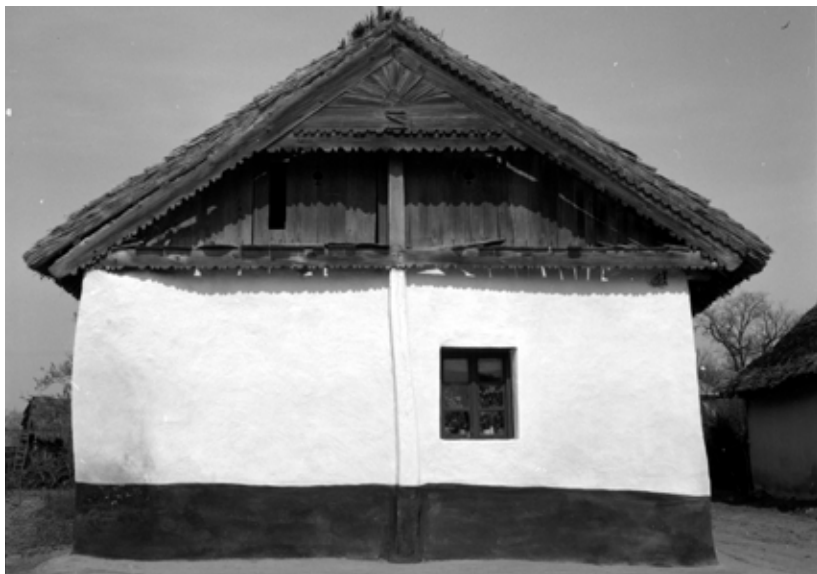
Abb. 2: Das ausgefüllte Lehmhaus aus Dulovce Nr. 275
