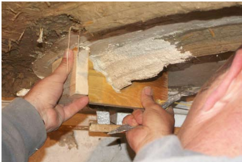
Abb. 4: Stetteldorf: Lehmstuck, Profilziehen
