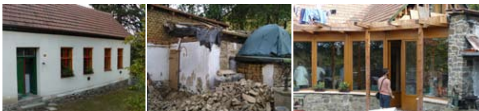
Abb. 1: Ansicht des Hauses vom Außen (links), Hofwand mit Zubauten, neuer Anbau im Hof (rechts)
