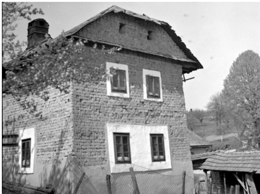
Abb. 5: Stockhaus aus Rohziegeln aus Stará Myjava Nr. 6. Foto J. Turzo, 1982. Fotoarchív SNM v Martine, Neg. Nr. 129048.
