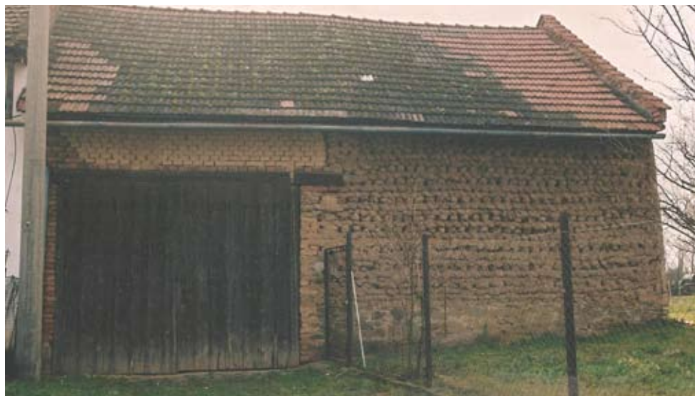
Abb. 1: Klenovice Nr.141 (Bezirk Prostějov)–Scheune aus Lehmklumpen Obr. 1: Klenovice čp. 141 (okr. Prostějov)–stodola z válkového zdiva
