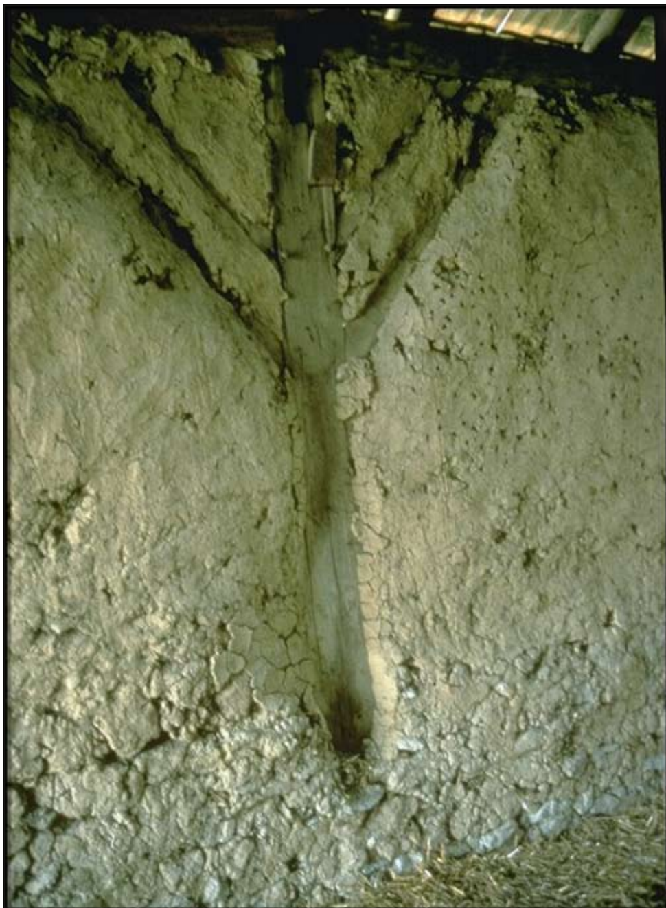
Abb. 1: Mit Wuzelmauern ausgefachte Ständerwand einer Scheune in Roggendorf, 2000.
