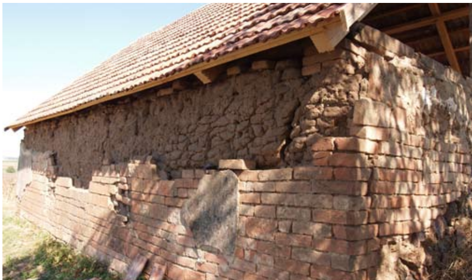
Abb. 1: Derflice, Bezirk Znojmo, Presshaus auf der Parzelle 223, westliche Wand. Foto 2013 J. Matuszková
