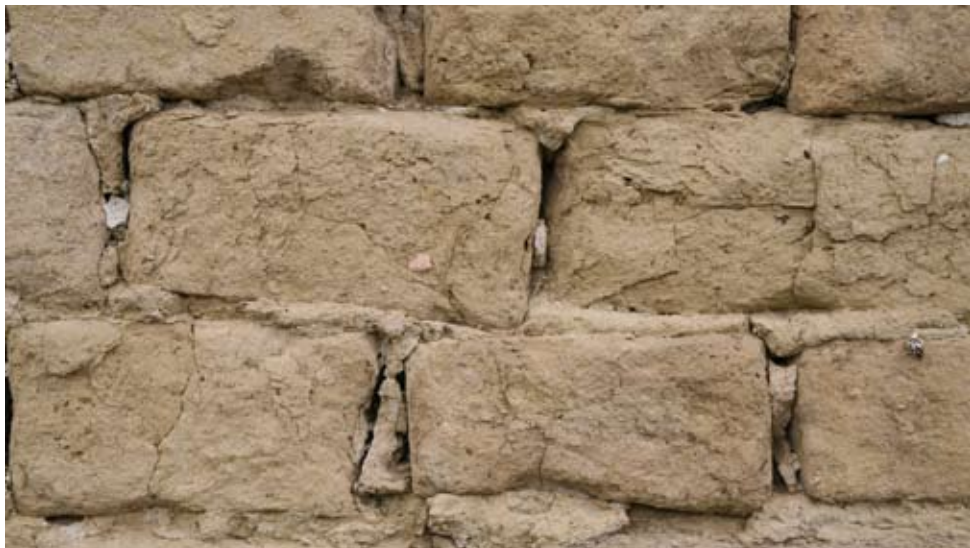
Abb. 4: Luftgetrocknete Ziegel aus Löss in der Kellergasse von Unterstinkenbrunn, der so gen. „Loamgrui“
