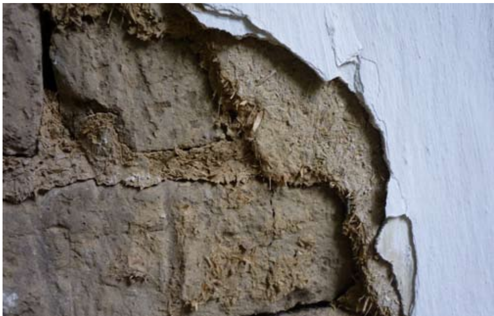
Abb. 2: Detailansicht Lehmsteine mit Lehmmörtel, Lehmunterputz Strohhäcksel und Kalkdeckputz
