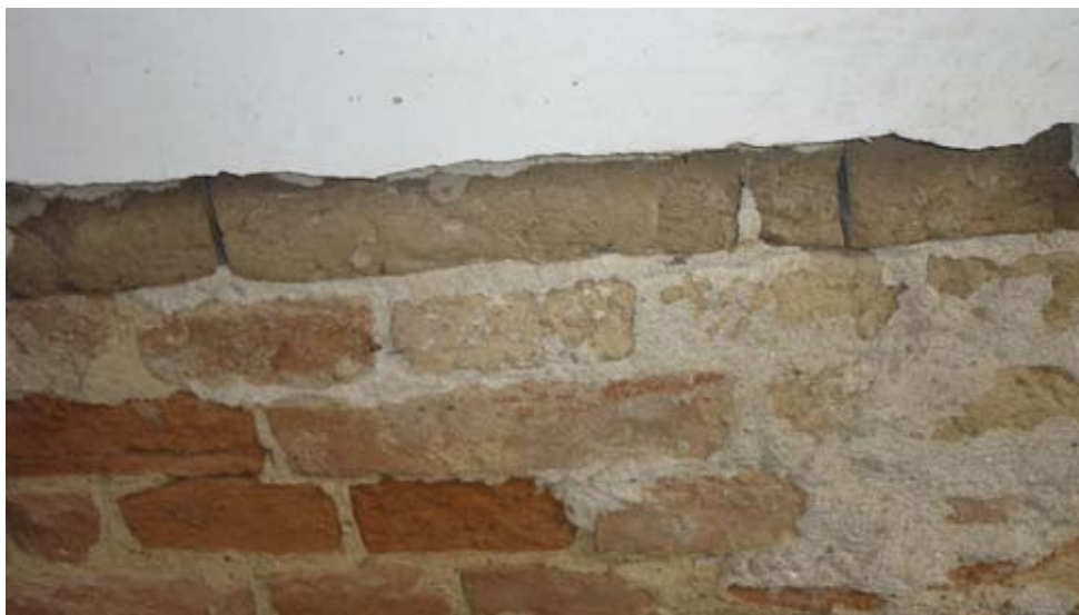
Abb. 3: Fußpunkt Lehmwand: Übergang gebrannte Ziegel–Lehmsteine
