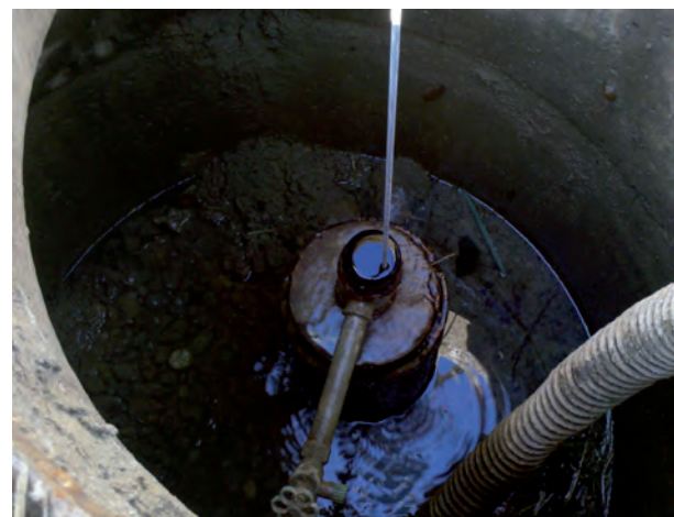
Abb. 5-4: Das Foto zeigt den Bohrkopf der Bohrung TB Singen bei laufender Messung. Der geringe artesischer Auslauf ist gut sichtbar, ebenso der geringe Durchmesser der Öffnung, der eine Flowmeter-Messung ausschloss.
