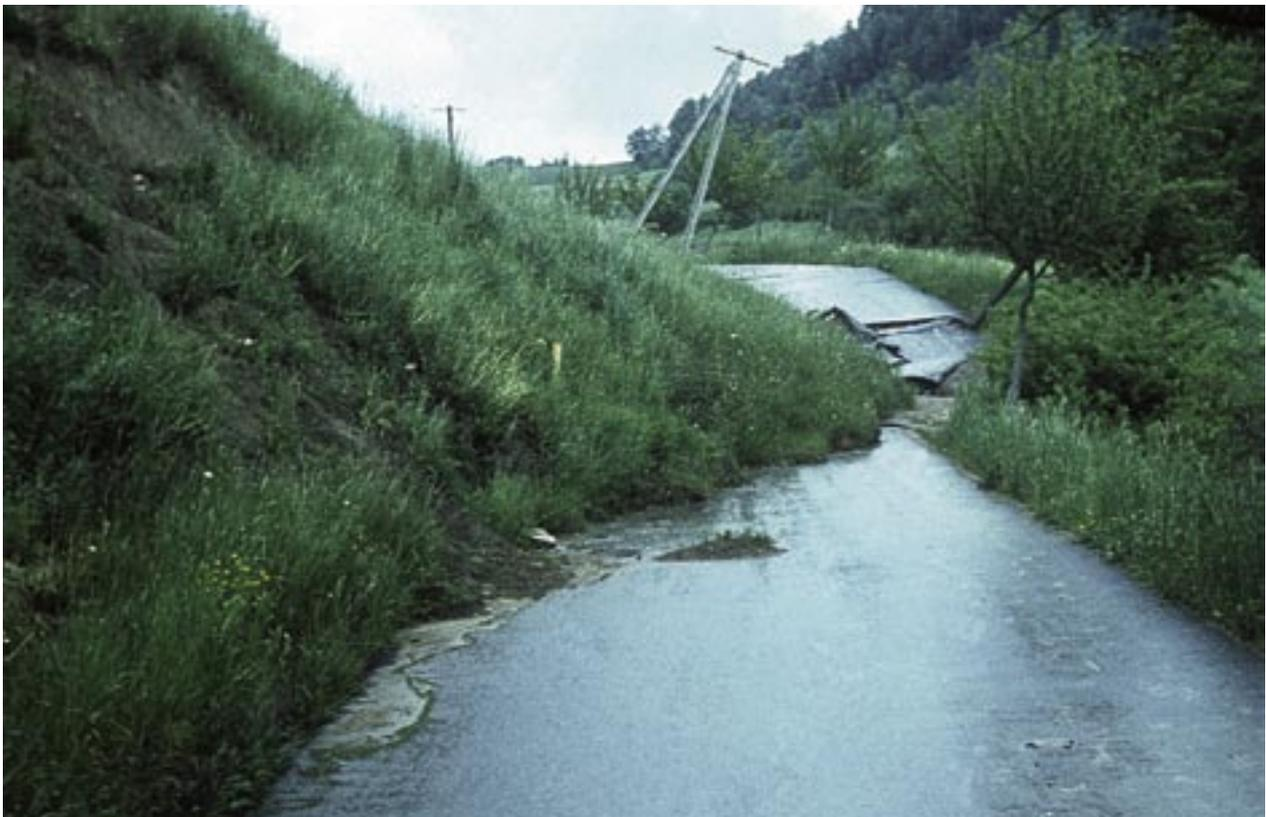
Abb. 18: Rutschung im Opalinuston an der Straße Achdorf – Eschach (Wutachgebiet)
