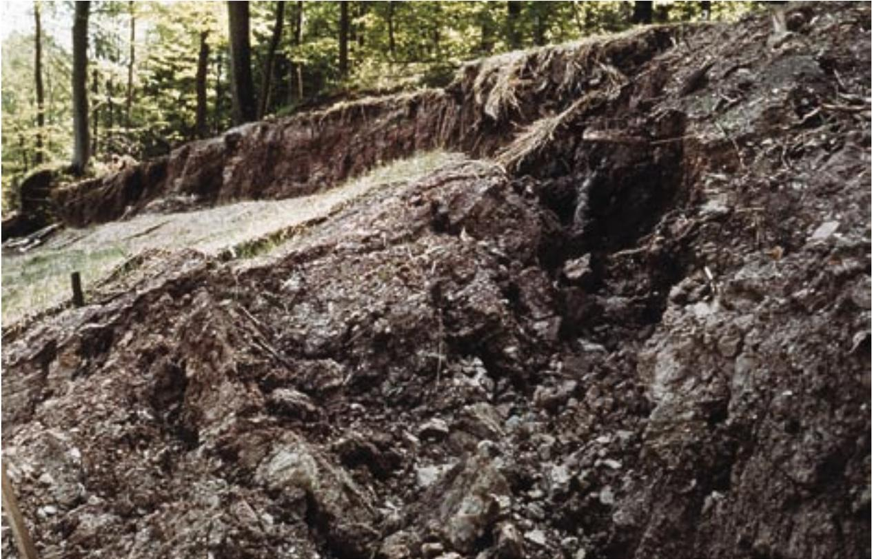
Abb. 29: Bergseitiger Abriss einer Großschollenrutschung im Gipskeuper des Wildenbergs (Foto BRUDER)
