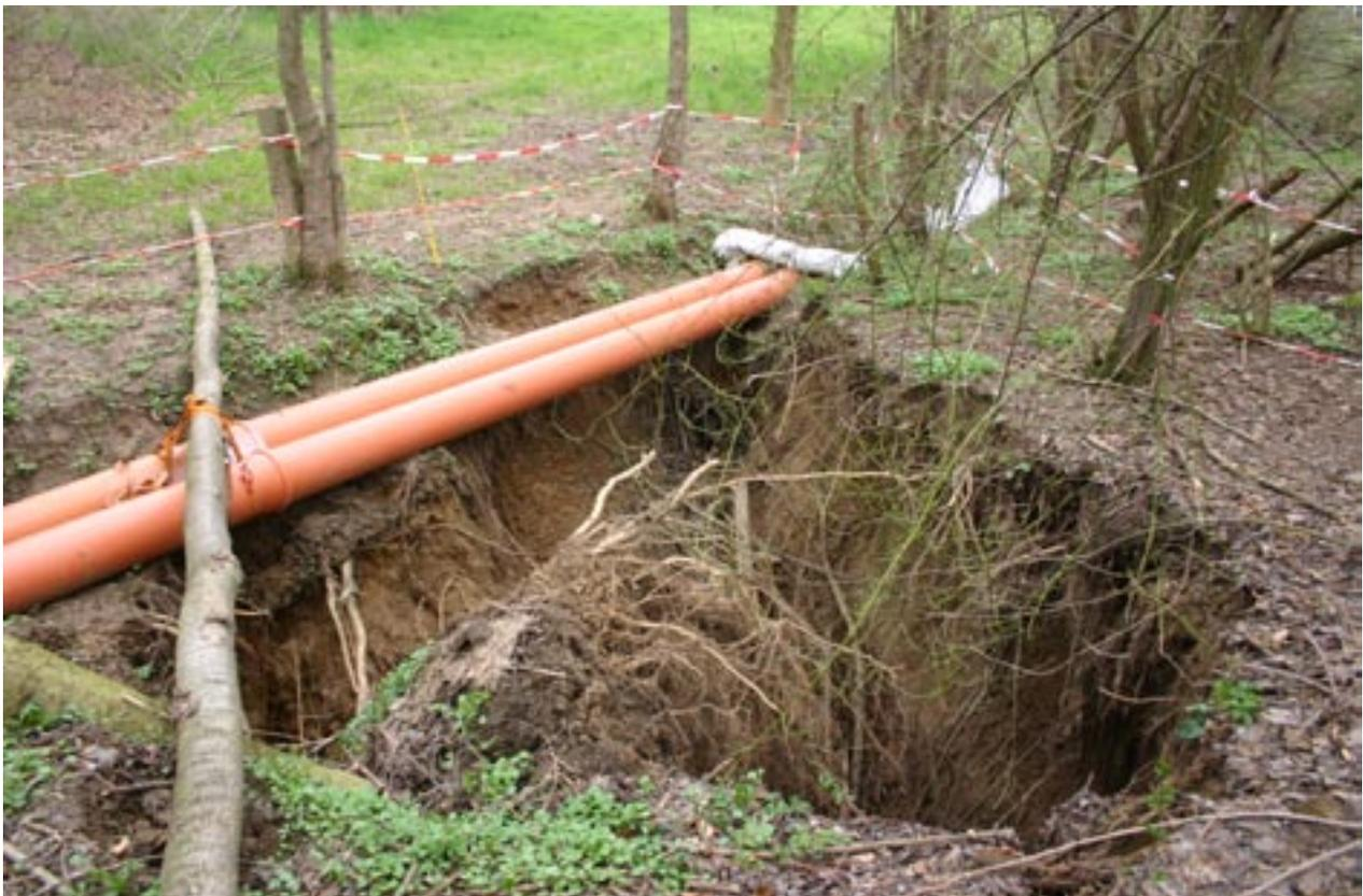
Abb. 39: Erdfall im Oberen Muschelkalk mit Nachbruch im Auenlehm des Maubachs, südlich Backnang. Der Bach versickerte vollständig im Oberen Muschelkalk und wurde deshalb in provisorischen Rohrleitungen über die Versickerungsstelle geführt
