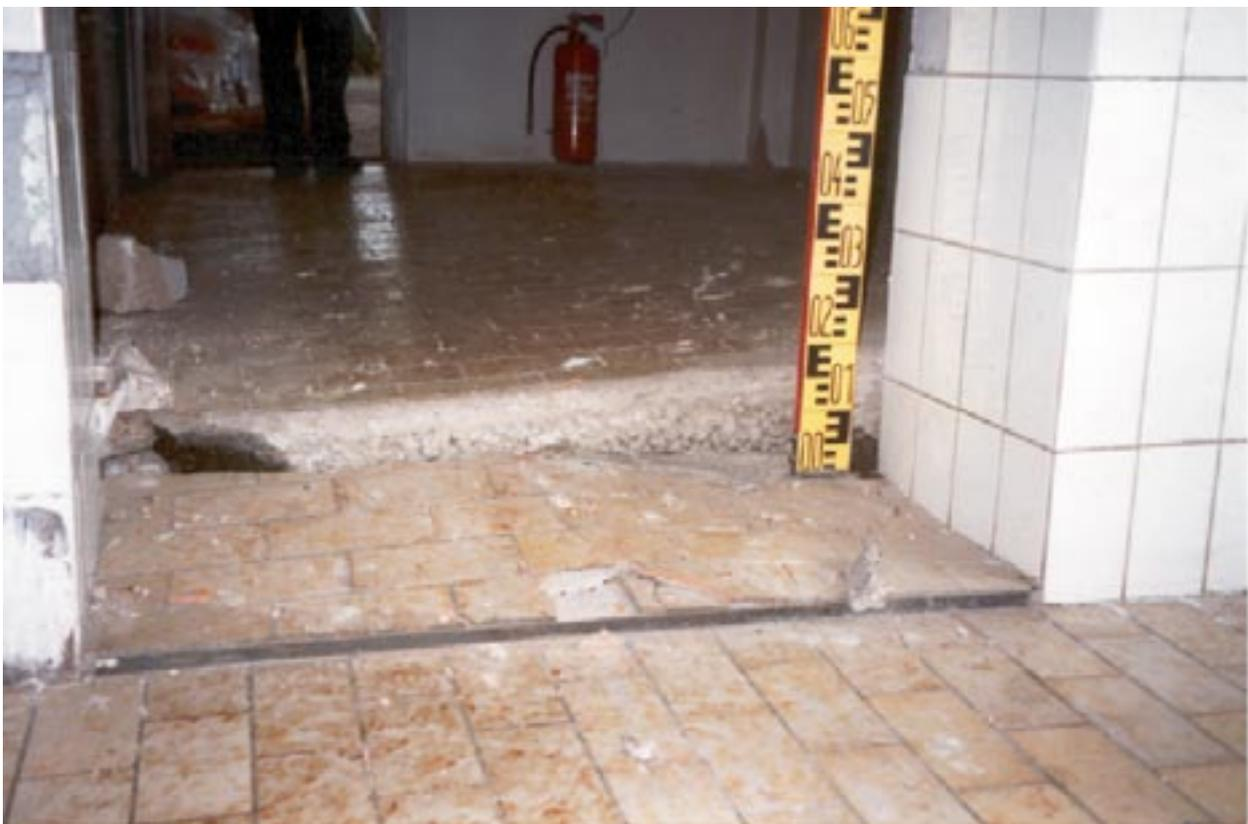
Abb. 44: Deformation des Fußbodens einer Halle im Zollernalbkreis durch Hebung im Posidonienschiefer (Foto RUCH)
