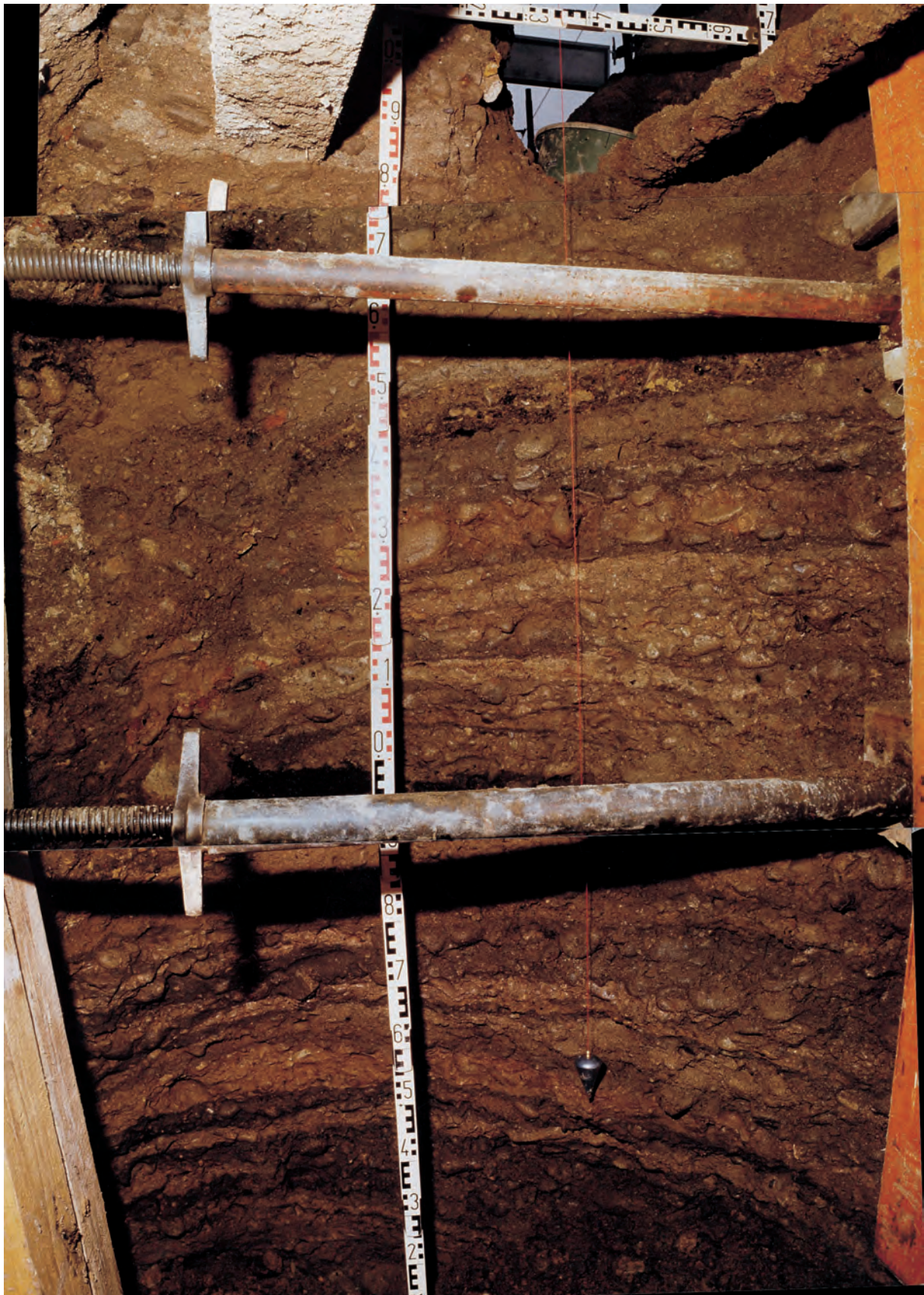
Abb. 27: Straßenaufschüttung in der Salzstraße
