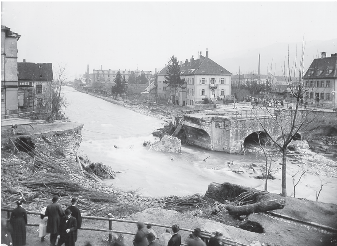
Abb. 22: Beim Hochwasser der Dreisam am 8. März 1896 zerstörte Schwabentorbrücke
