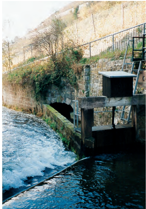
Abb. 28: Abzweigung des Bächlekanals vom Gewerbekanal und Eingang in den Bächlestollen hinter dem Gebäude Kartäuserstraße 47a
