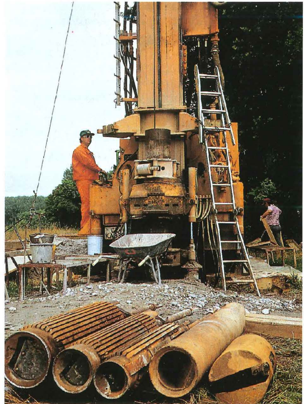
Abb. 29: Bohrung bei Schutterwald zur rohstoffgeologischen Erkundung der Kies- und Sandvorkommen des Oberrheingrabens mit drei Kiespumpen (links), einer Kiesbüchse und einer Schappe (rechts) im Vordergrund
