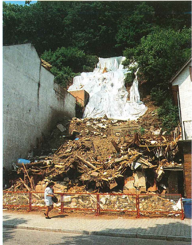
Abb. 25: Oppenau (Lkr. Ortenau), durch Hangrutschung völlig zerstörtes Wohnhaus
