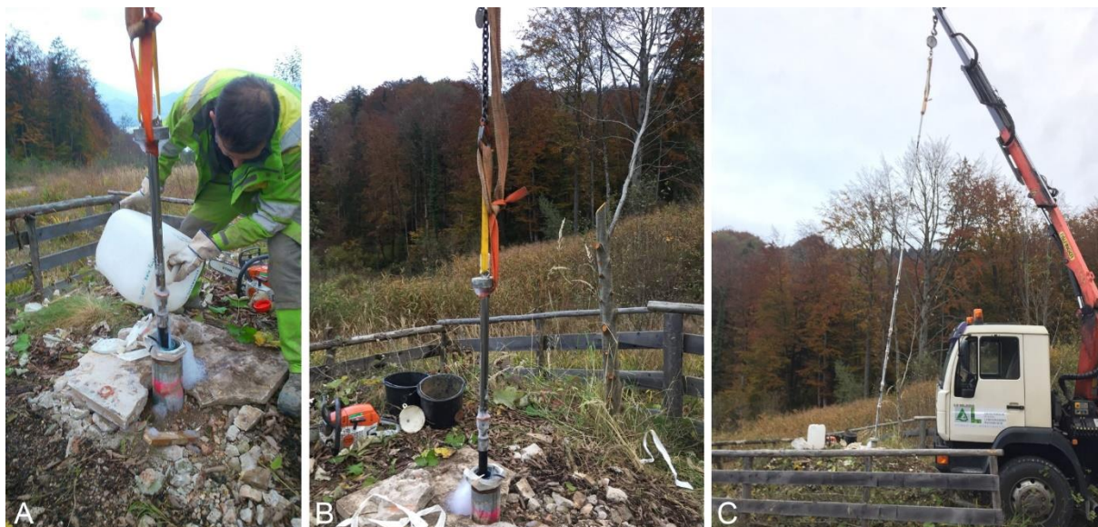
Abb. 13: Ausbau des DMS Inklinometers; (A) Einfüllen eines Gleitmittels für das reibungsärmere Ziehen des Inklinometers; (B) und (C) Ziehen des Inklinometers mittels Kranlastwagen
