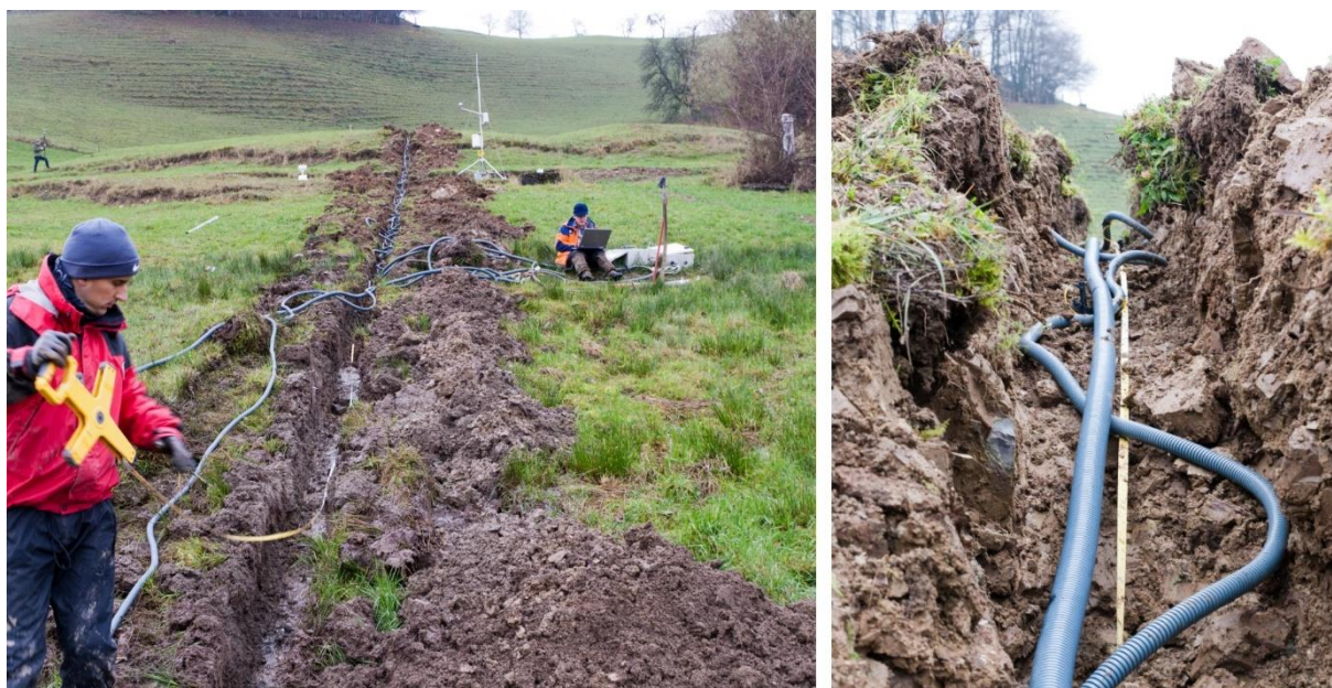
Abb. 4: Installation der geoelektrischen Messkabel - Übersicht (links), Detailansicht in Künette (rechts)
