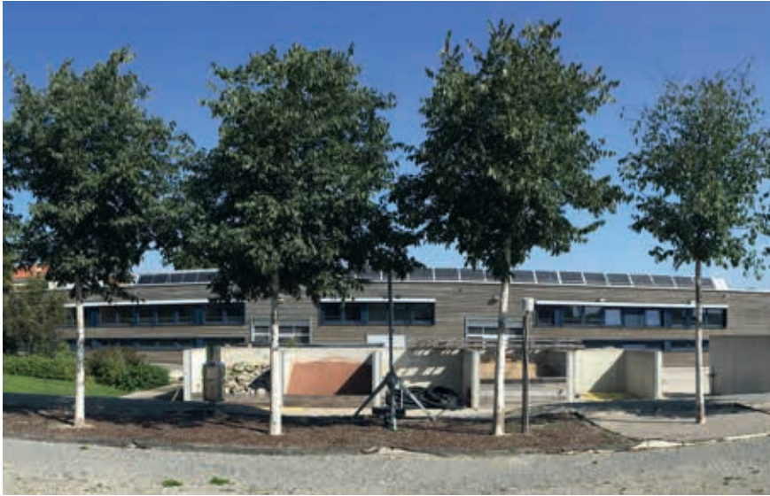
Straßenbäume: In der Lysimeteranlage Jägerhausgasse werden spezielle Baumsubstrate getestet.
