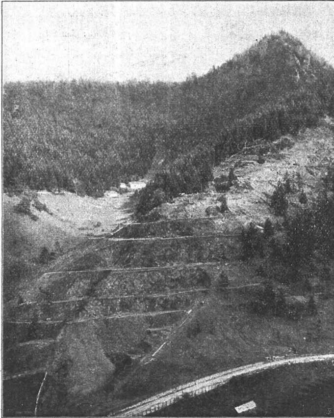
Fig. 42. Der Eisenerztagbau Drožkovac bei Vareš. Auf den oberen Terrassen mehr Roterz, auf den unteren vorwiegend Pelosiderit.
