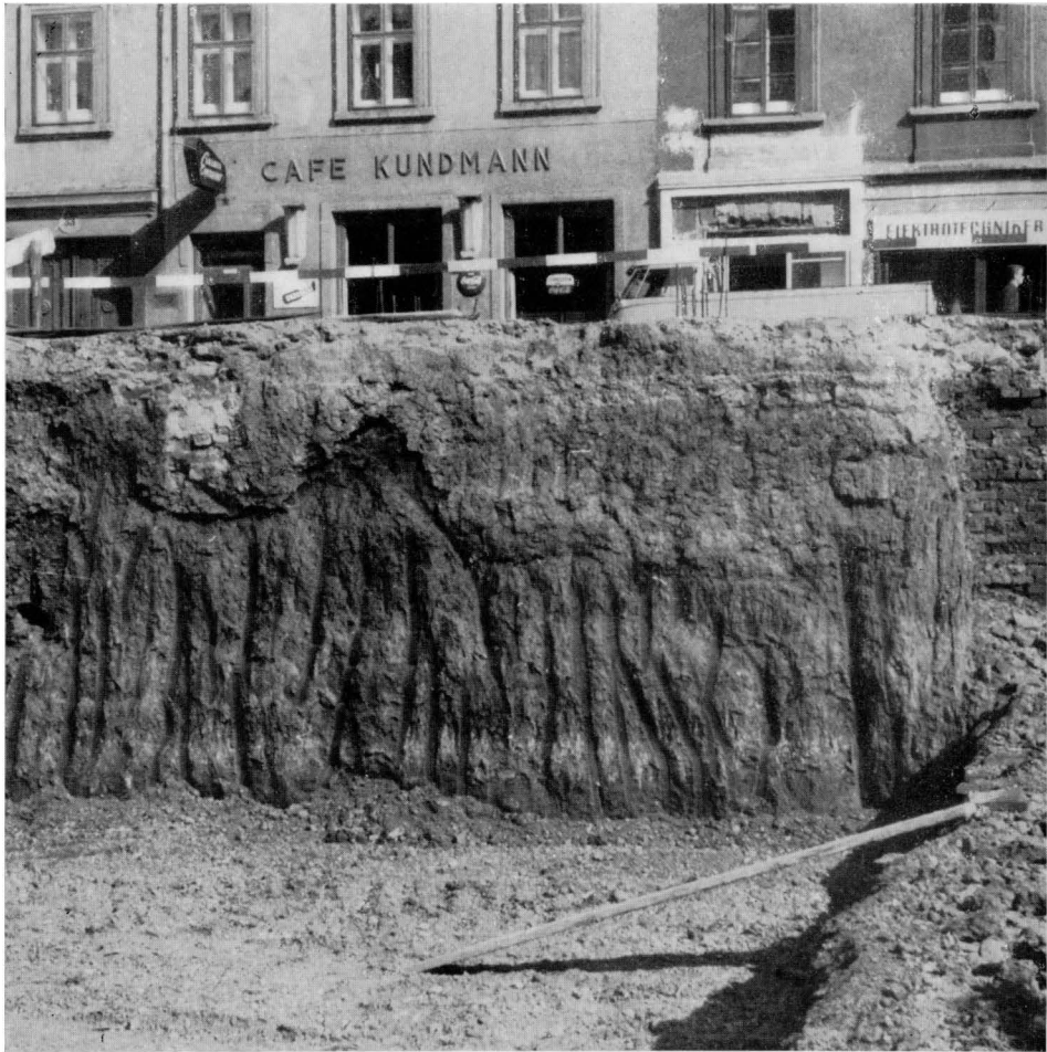
Fototafel 11: Löß auf Plattelschotter, Oberkante Stadtterrasse. Löß, durch Bodenbildungen gegliedert, Sohle der Baugrube Plattelschotter. Wien III, Kundmanngasse
