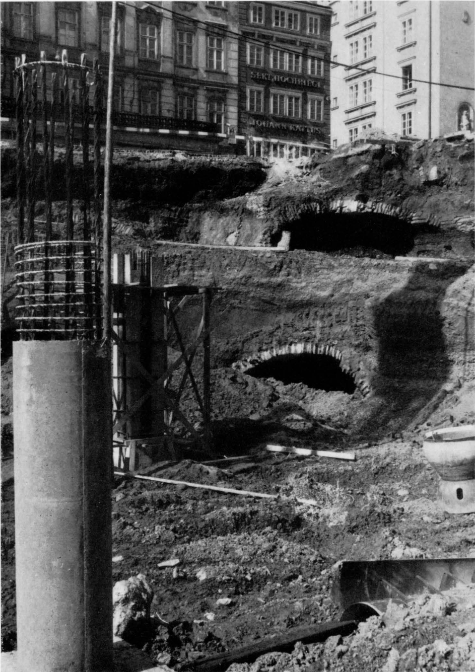
Fototafel 13: Kellersysteme im Löß . Schwemmlöссе, wechsellagernd mit Plattelschotter. Wien I, Am Hof, Baugrube Tiefgarage, 1962
