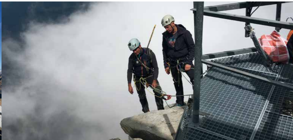
Arbeiten im Rahmen der Permafrost-Messungen Work to support the permafrost measurements
