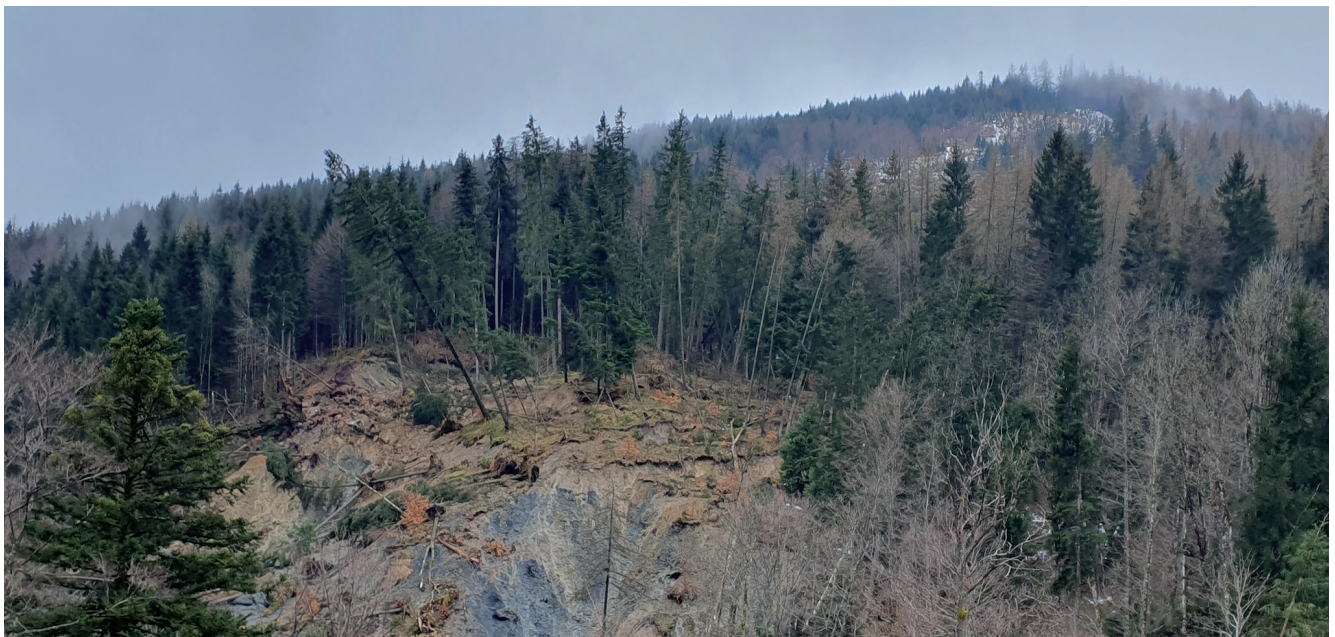
Abb. 10. Hochebenalm-Rutschung am 17.04.2023: östliche Rutschungstirn mit „betrunkenem Wald“ und der Kontaktzone zwischen Kössen-Formation und Grundmoräne. Oberhalb der aktiven Rutschung deuten weitere Hangverflachungen innerhalb einer in 1.000 m Seehöhe auslaufenden Hangkonkavität die inaktive Fortsetzung der Hangbewegung an. Am oberen Ende der Anbruchkante markiert ein Quellaustritt den Übergang zu den verkarsteten Adnet-er Kalken (Abb. 8), die hier punktuell aufgeschlossen sind.
