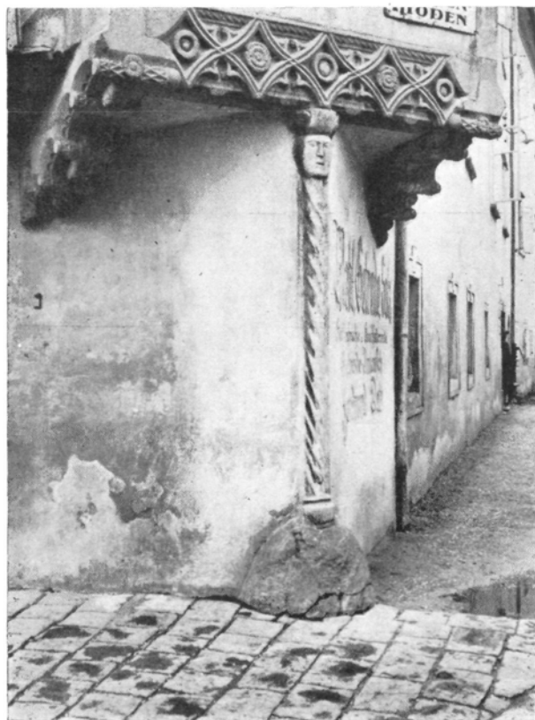
Abb. 5. Ecke des Hauses Wels, Stadtplatz 24.
