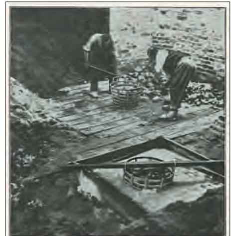
Abb. 65. Trockenlöschchen durch Eintauchen in Kötben. Der unruhige Wasserspiegel (vorn) zeigt, daß die Wassernahme noch nicht beendet ist. Oben rechts wird ein zweiter Korb gefüllt. Links sieht man den Fuß des Löschaufens.
