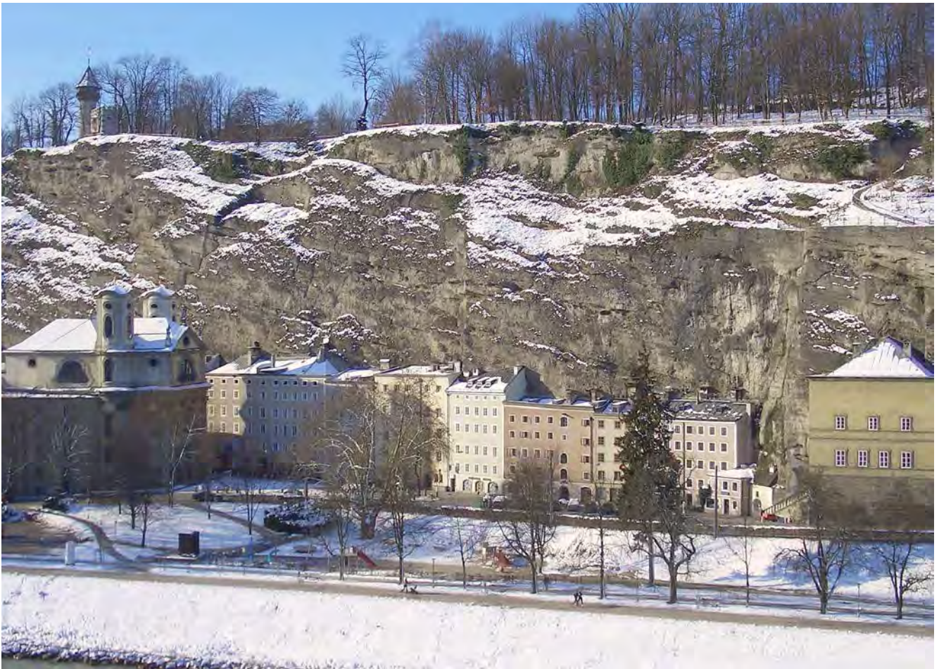
Abb. 7. ESE-Wand des Mönchsberges zwischen Klausentor (rechts) und Markuskirche (links). Die historische Bebauung reicht unmittelbar an den Wandfuß, Keller unterschneiden diesen. Blick vom Turm der Christuskirche nach SW. Foto: J.-M. Schramm.
