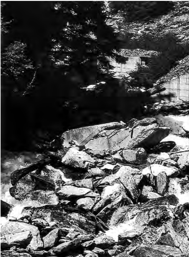
Abb. 37. Völlige Zerstörung der Sperrenabstaffelung. Aufnahme Anfang der 1980er Jahre.
