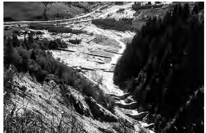
Abb. 2. Blick vom Fuß der Talzuschubsstirn auf den Schwemmfächer und der durch die Murenkatastrophe von 1966 zerstörten Ortschaft Putschall. Im Vordergrund sind die nach der Katastrophe neu errichteten Betonsperren.
