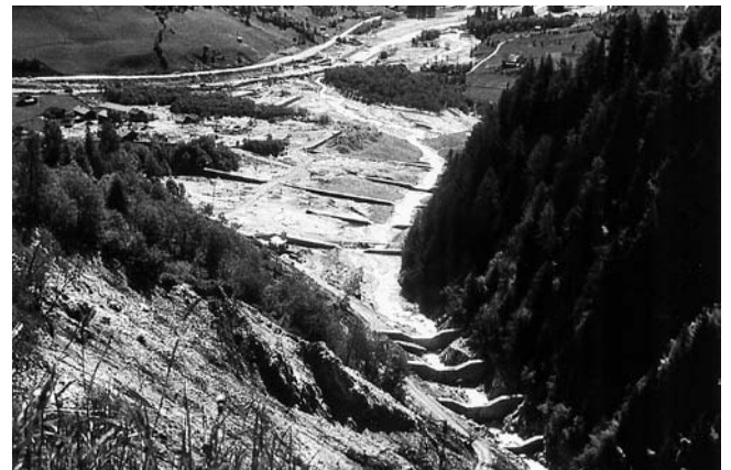
Abb. 2. Blick vom Fuß der Talzschubsstirn auf den Schwemmfächer und der durch die Murenkatastrophe von 1966 zerstörten Ortschaft Puttschall. Im Vordergrund sind die nach der Katastrophe neu errichteten Betonsperrern.
