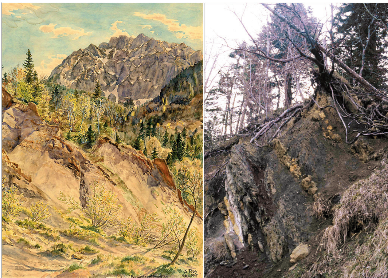
Abb. 3. Auch Sigmund PREY war von der „Roten Kirche“ am Fuße der Traunstein-Nordwand offenbar sehr angetan. Wie sein Aquarell aus dem Jahre 1947 (links) aus dem Archiv der Geologischen Bundesanstalt im Vergleich zu heutigen Aufnahmen (rechts) aber zeigt, unterliegt diese Felsrippe einem sehr raschen Abtragungs- und Zerfallsprozess (das Foto dokumentiert den zentralen Teil des Rückens auf dem Aquarell; den darauf ersichtlichen, rechten Teil gibt es nicht mehr). Von einem „Versinken“ kann aber keine Rede sein. Und auch die „Bergmandlkreuzer“, nach dem Volksmund das versteinerte Geld der Kobolde, aus dem sie bestehen soll, sind nichts Anderes als Kalkskelette von Großforaminiferen (u. a. Nummuliten), die einst im seichten Eozän-Meer lebten.
