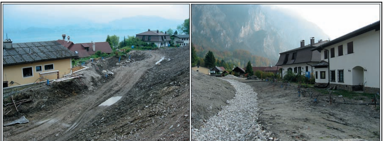
Abb. 14. In Anlage befindliche (links) und fertige Drainageschlitze (rechts) hinter den Häusern auf dem 1910er bzw. 2008er Erdstrom des Gschliffgrabens. Die blauen Rohrstützen sind Brunnen bis auf die aktive Gleitfläche in ca. 20 m Tiefe, die allmählich zum Übergang von einem Gleit- in einen Kriechprozess führten und die Rutschung zum Stoppen brachten (freundl. münd. Mitteilung von Prof. Dr. R. POISEL, TU-Wien).
