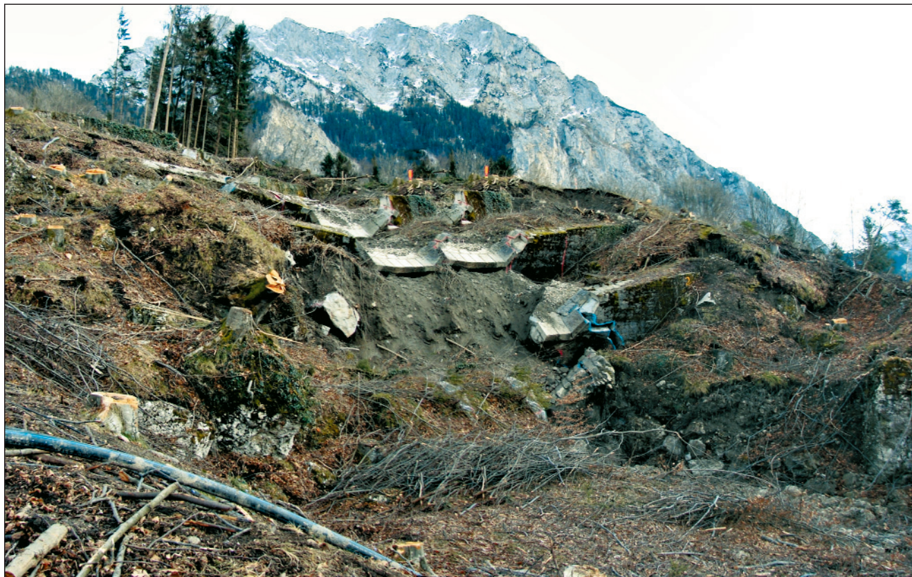
Abb. 12. Reste der Talsperren des Gschlifbaches (03/2008 EN).
