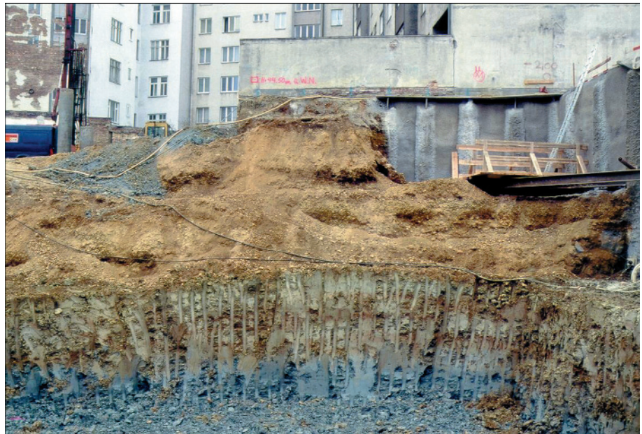
Abb. 2. Baugrundaufschluss im 4. Wiener Gemeindebezirk (1040 Wiedner Hauptstraße, zwischen Schusswallgasse und Hollgasse). Unter den Kiesen der Arsenalterrasse liegt zunächst ockerfärbig verwitterter „Tegel“ und dann der frische, blaugraue „Tegel“ des Pannoniums.
