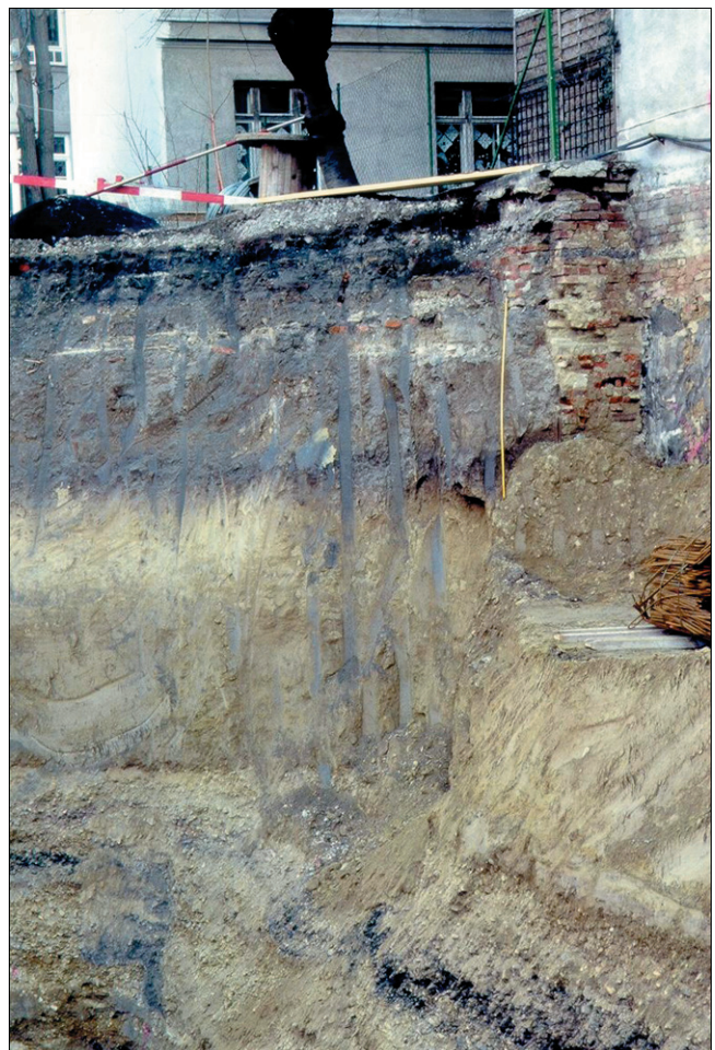
Abb. 3. Baugrundaufschluss im 3. Wiener Gemeindebezirk (Barichgasse, Höhe Arenberggasse), ganz in der Nähe des neuen Standorts der Geologischen Bundesanstalt. Die Abfolge der Stadterrasse zeigt unter dem Mutterboden zunächst Anschüttung, dann Löss und schließlich „Plattelschotter“.
