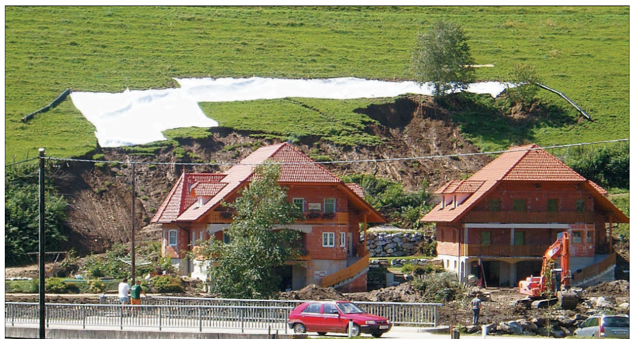
Abb. 1. Von einer Rutschung betroffene Neubauten in der Gemeinde Haslau (Steiermark).
