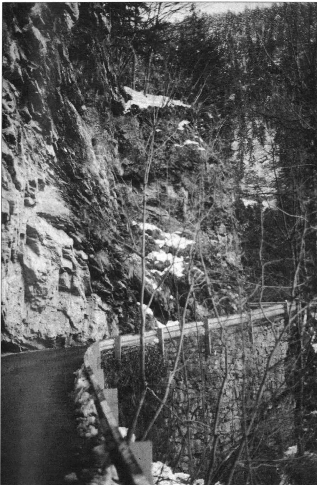
Abb. 7. Meschach-Götzis. Ansicht der Straßenquerung der Meschacher Antiklinale auf der Stützmauer „Fuchsfalle“ vor der Sanierung.
