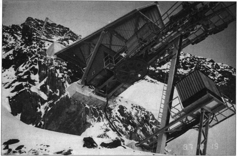
Abb. 19. Gletscherschleplift Daunferner II (Stubai Gletscher-Schigebiet). Horizontal verankerte Bergstation mit Antrieb, Abspannung und Trafo.
