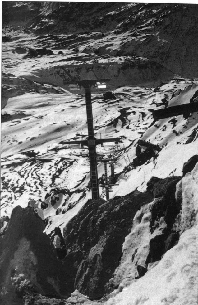
Abb. 14. Doppelsesselbahn Schindlergrat St. Anton a. A. Ansicht der verankerten Stützen in den Arlberg- schichten der Südostwand.
