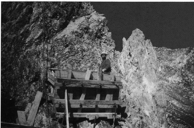
Abb. 20. Lawinensprengseilbahn Kaminspitzen (Nordkette Innsbruck). Horizontal verankertes Stützenfundament im Bauzustand.
